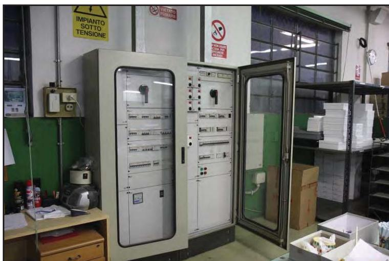
**Fotografia 4.5 - Il Quadro Elettrico Generale da 35 kW di potenza installata.**
