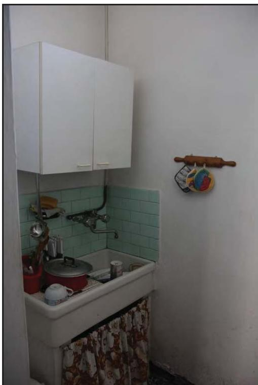
**Fotografia 3.7 - La zona sinistra della cucina, con il tubo l'adduzione dell'acqua calda fuori traccia.**
