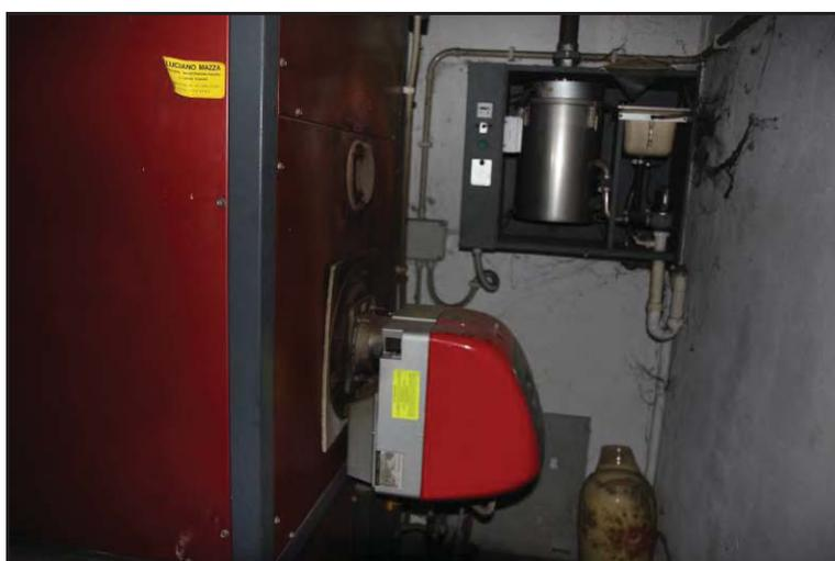
**Fotografia 4.8 - Il bruciatore a gasolio della caldaia, in centrale termica.**
