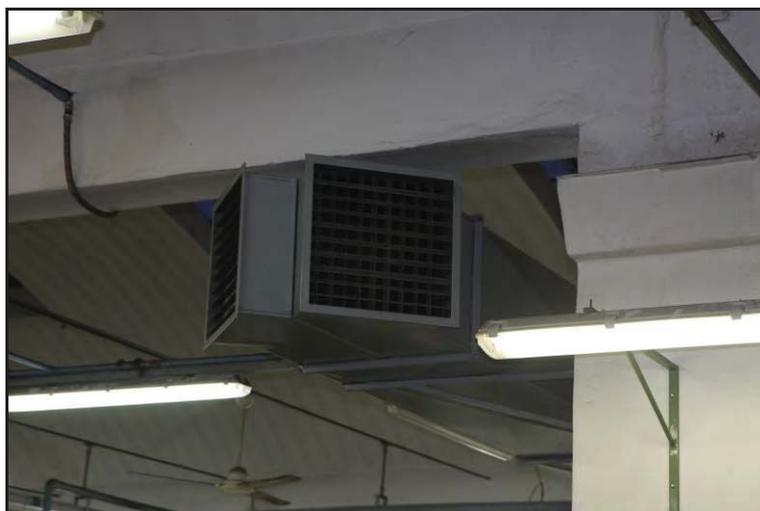
**Fotografia 4.7 - Il canale di distribuzione dell'aria calda.**
