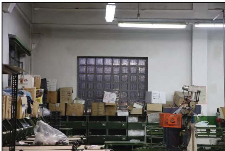
**Fotografia 4.4 - Una delle prese di luce verticali realizzate con mattonelle di vetrocemento.**
