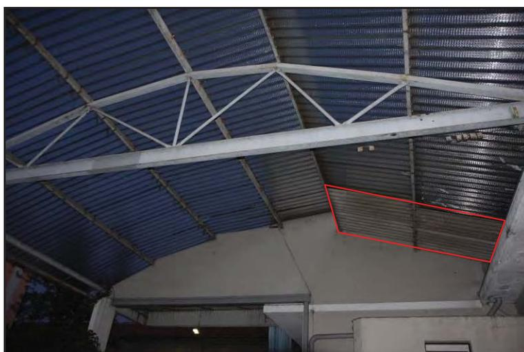
**Fotografia 4.9 - La copertura vetrata della corte di carico-scarico, con la parte in Eternit evidenziata in rosso.**
