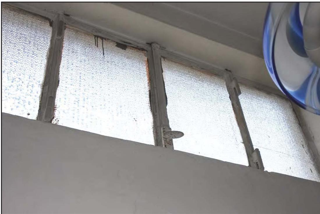
**Fotografia 3.11 - I serramenti della cucina e del bagno, di tipo industriale.**
