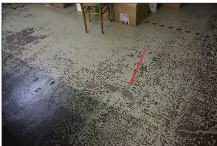
**Fotografia 4.6 - Il pavimento in gomma incollata, con evidenziati buchi per l'usura.**
