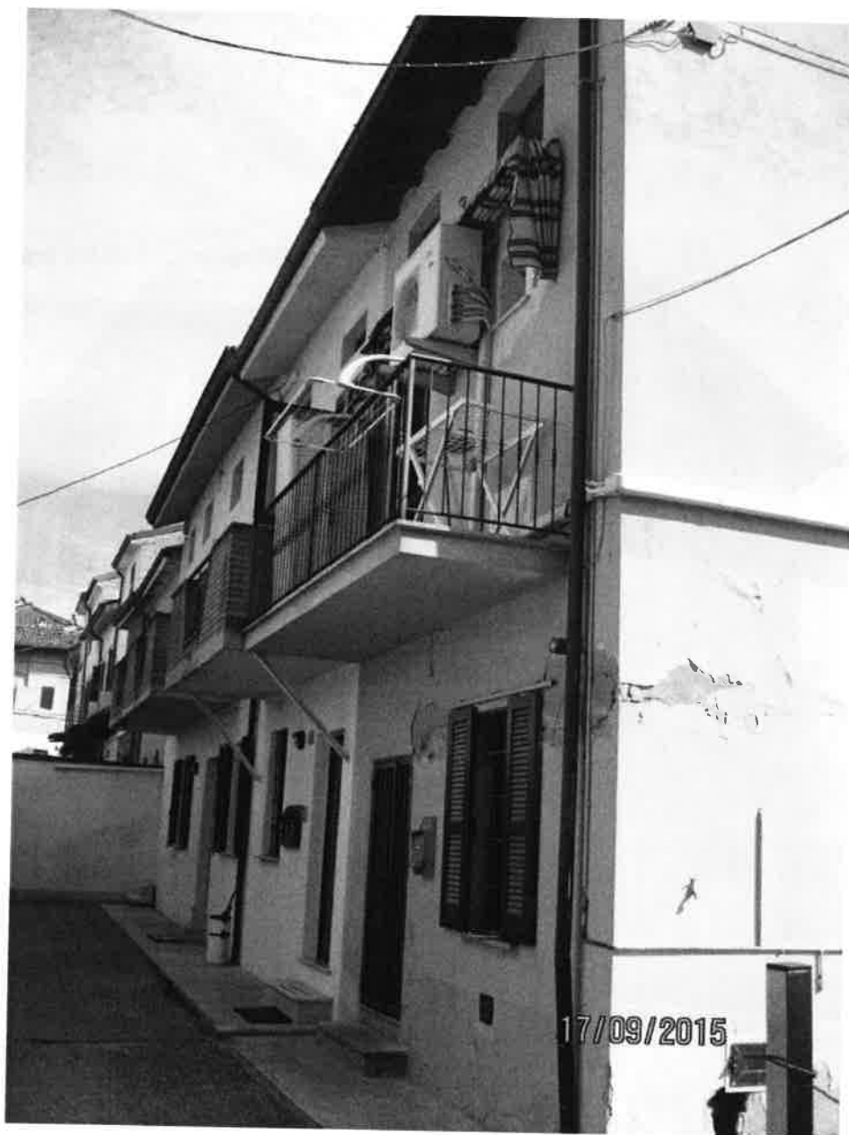
foto 02 – prospetto Nord del fabbricato.
