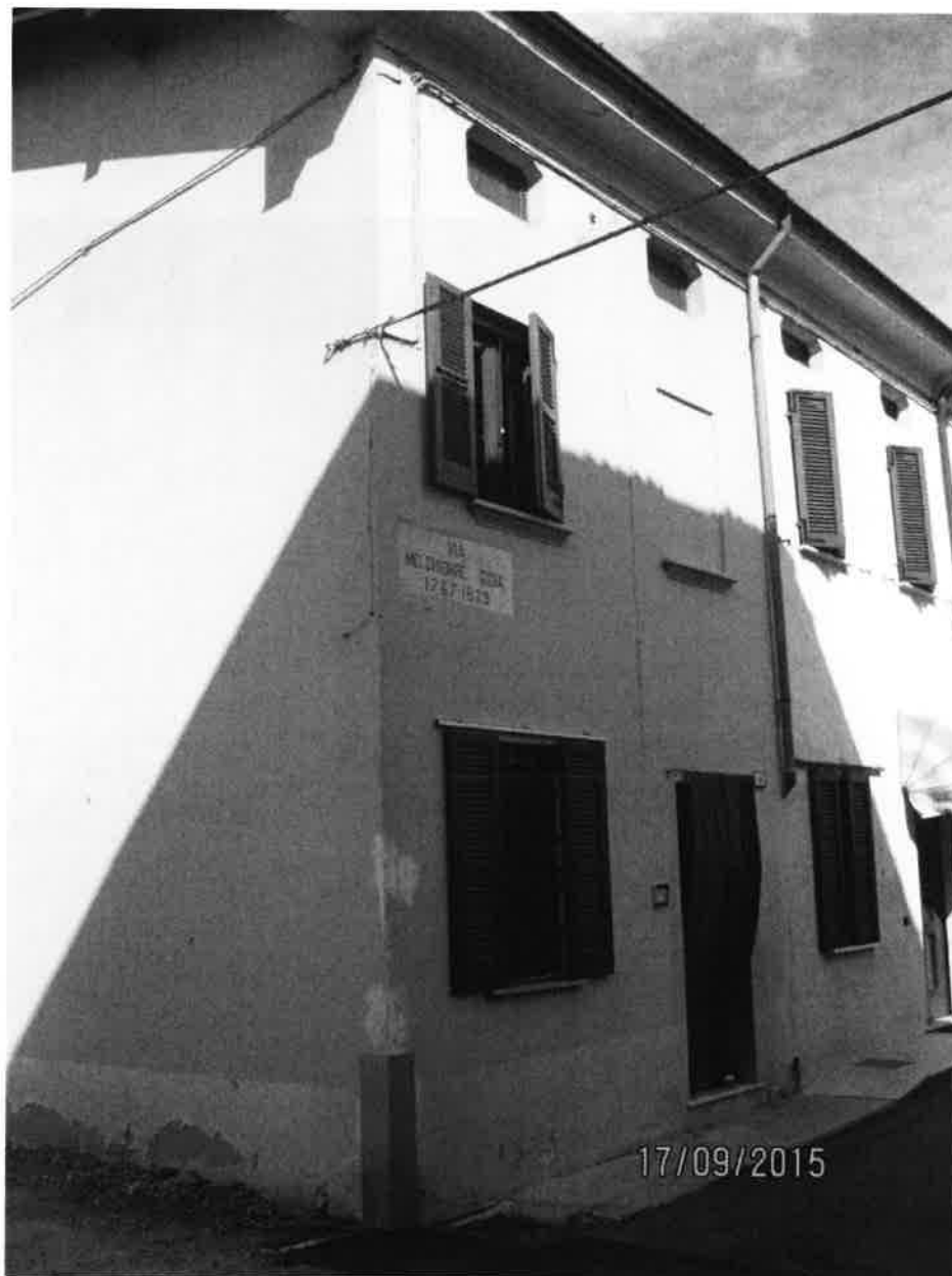
foto 03 – prospetto Sud del fabbricato, su via M. Gioia
