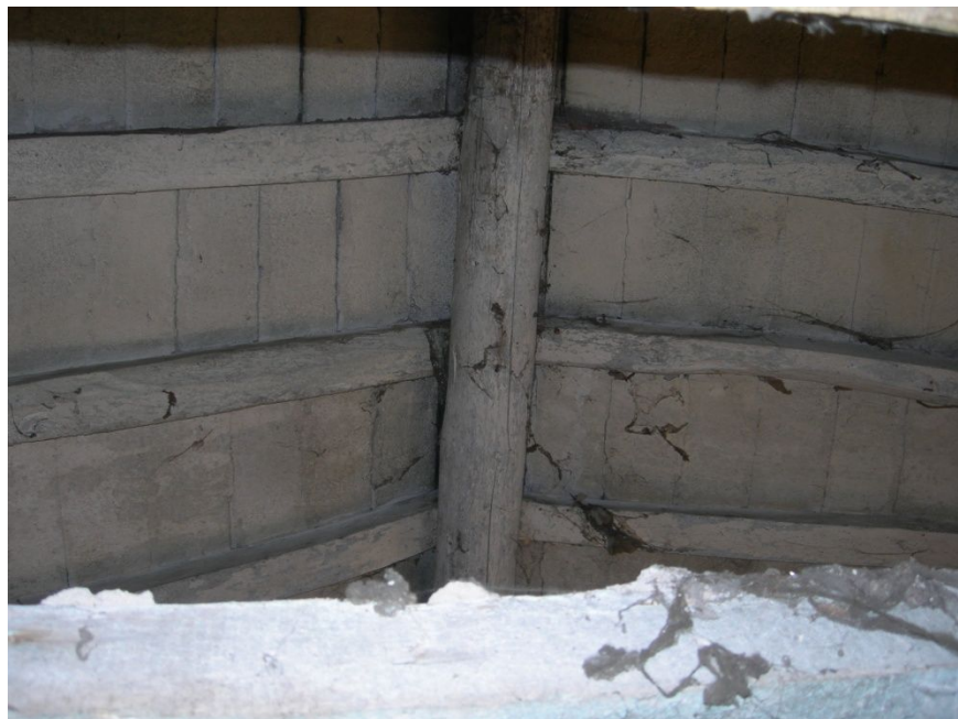
Particolare della copertura al primo piano
