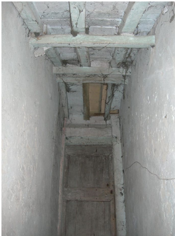
Ingresso al primo piano
