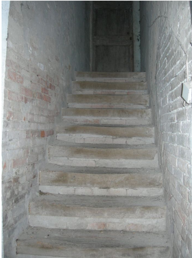
Seconda scala d'accesso al primo piano
