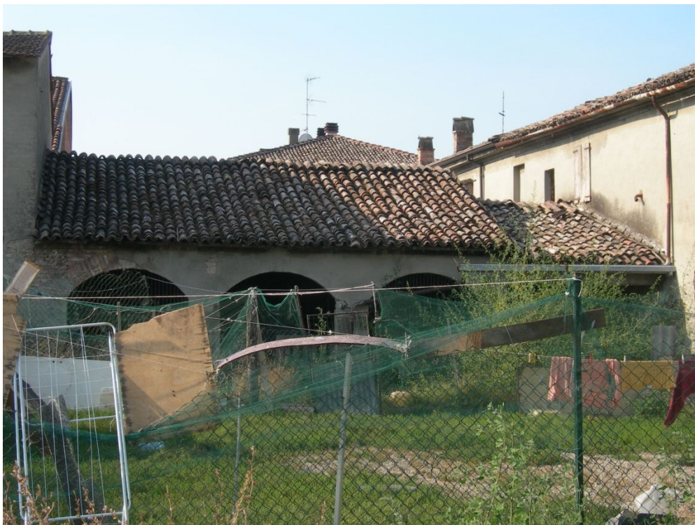
Locali deposito ed autorimessa
