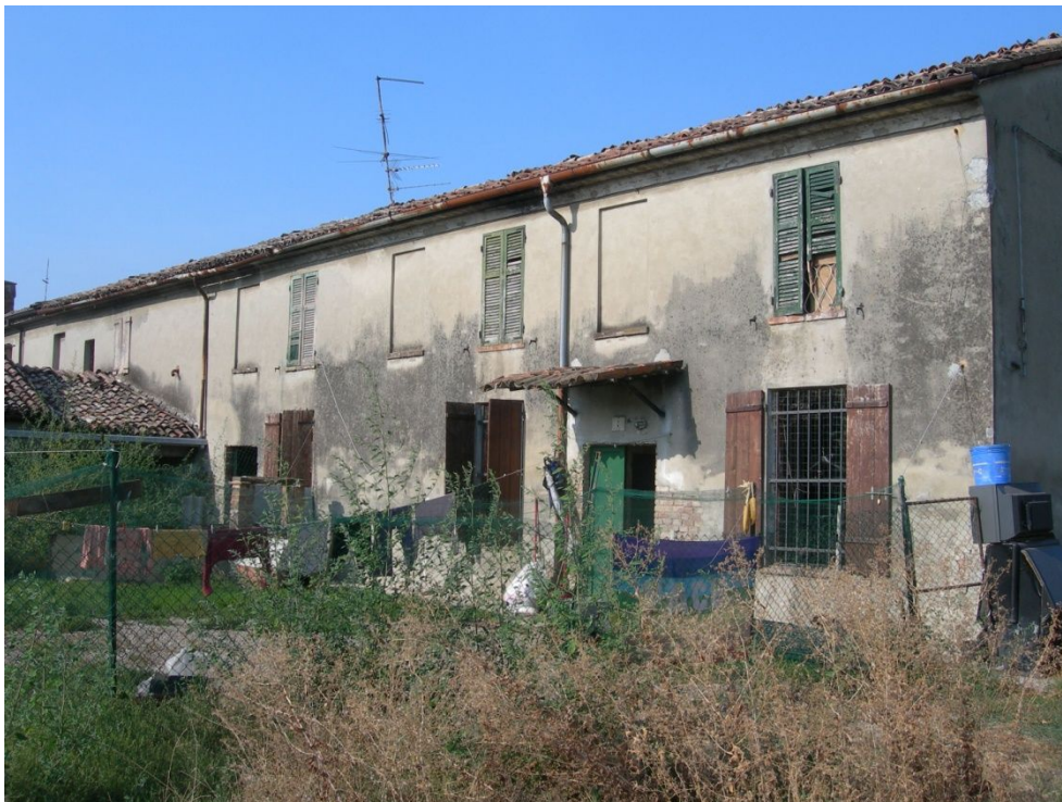
Fronte OVEST – Verso corte interna
