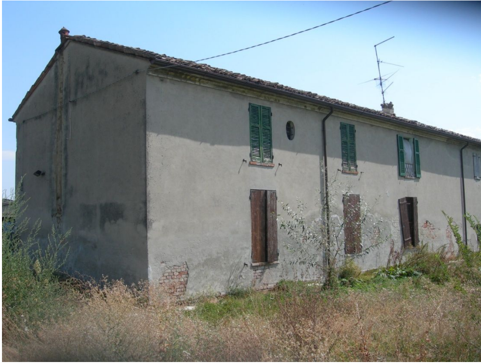
Fronte NORD/EST – Verso Strada provinciale di Besenzone
