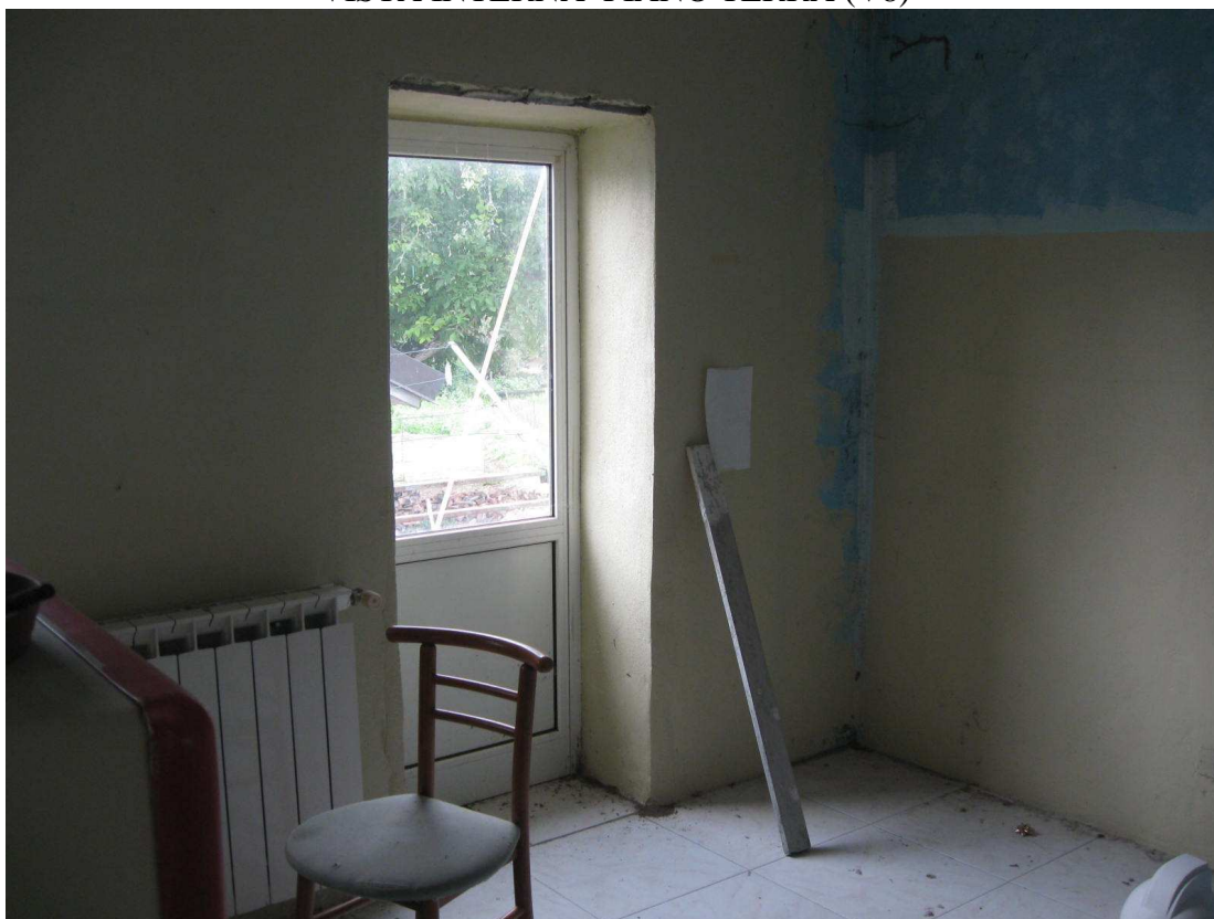
VISTA INTERNA PIANO TERRA (V8)
