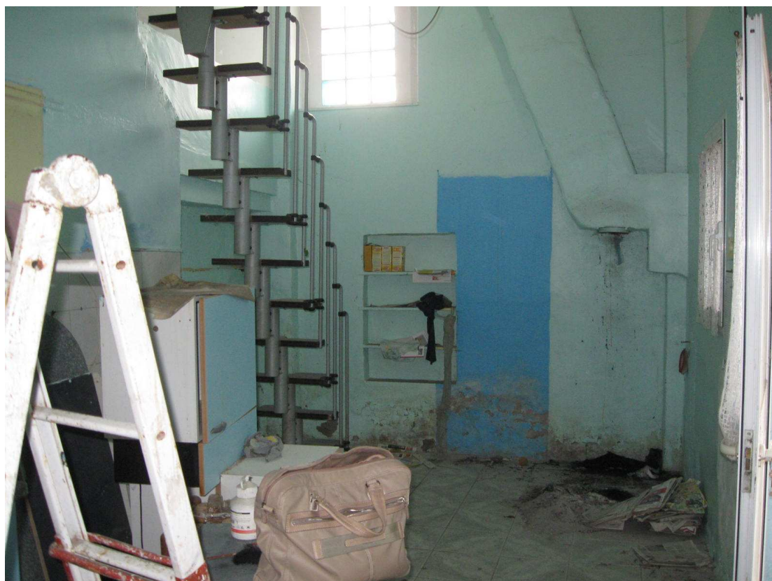
VISTA INTERNA PIANO TERRA (V5)
