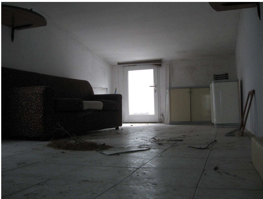
VISTA INTERNA SOFFITTA PIANO SECONDO (V12)
