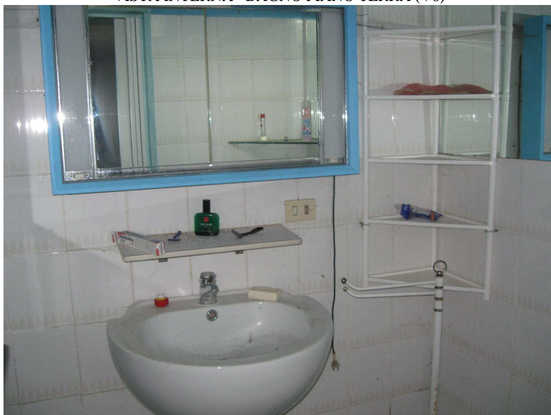
VISTA INTERNA BAGNO PIANO TERRA (V6)
