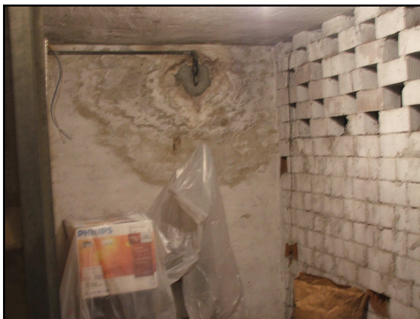
Foto 17: Cantina di pertinenza dell'unità immobiliare oggetto dell'esecuzione.
