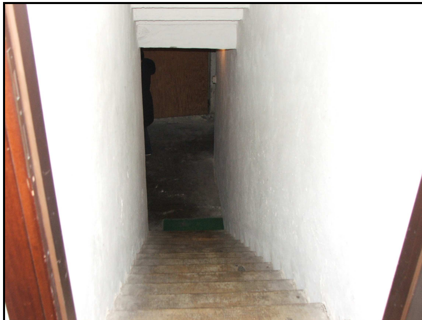
Foto 15: Rampa della scala condominiale di accesso al piano interrato.
