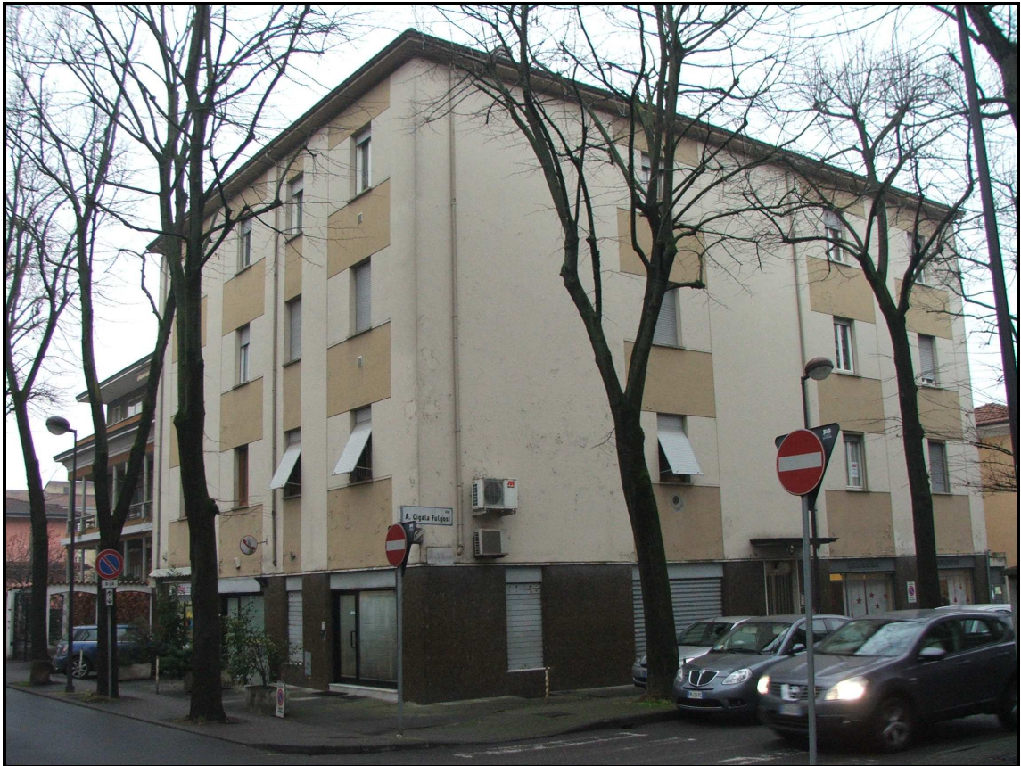
Foto 3: Vista da nord – est del fabbricato condominiale (dalla via Lanza).
