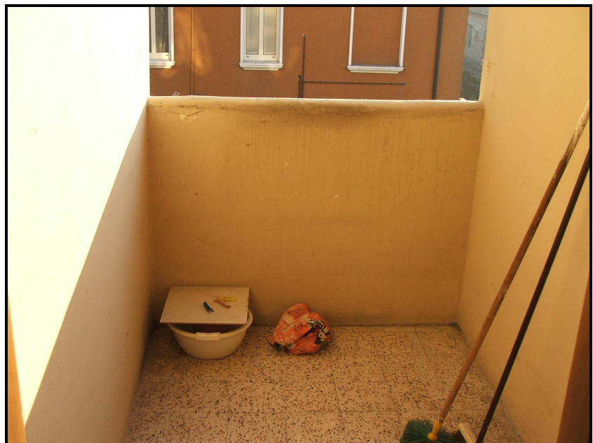
Foto 14: Terrazzino accessibile dal pianerottolo del vano scala.
