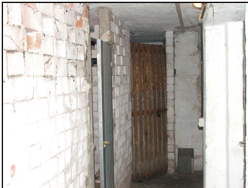
Foto 16: Corridoio di accesso alle cantine al piano interrato.
