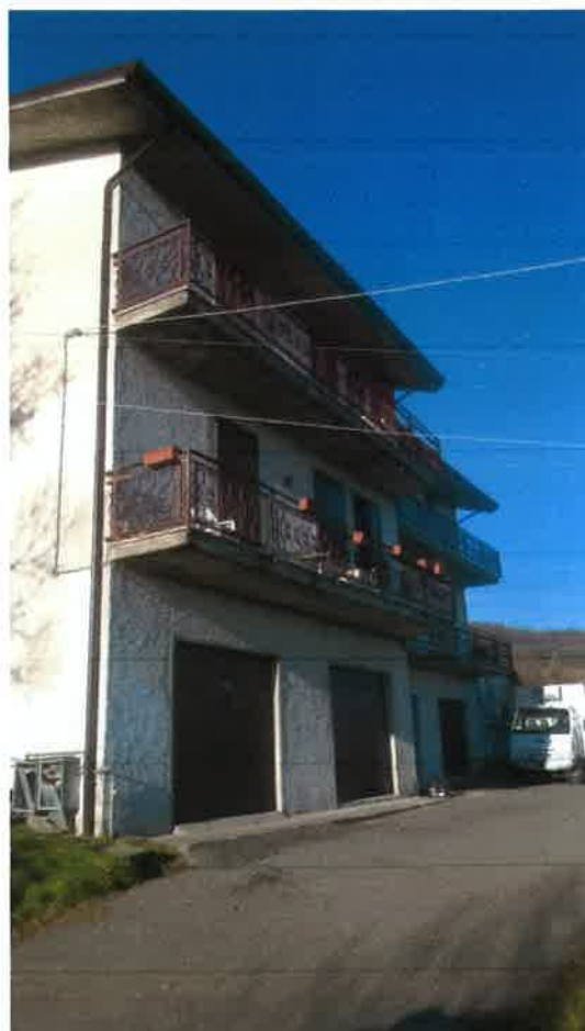
FOTO 2: vista della palazzina dalla strada di accesso. Al piano primo l'appartamento oggetto di stima.
