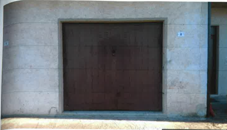
FOTO 18: vista del portone di ingresso all'autorimessa
