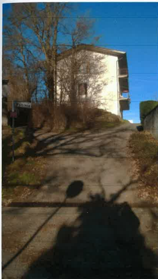
FOTO 1: vista della palazzina in cui sono inserite le unità immobiliari oggetto di stima, dalla strada di accesso.
