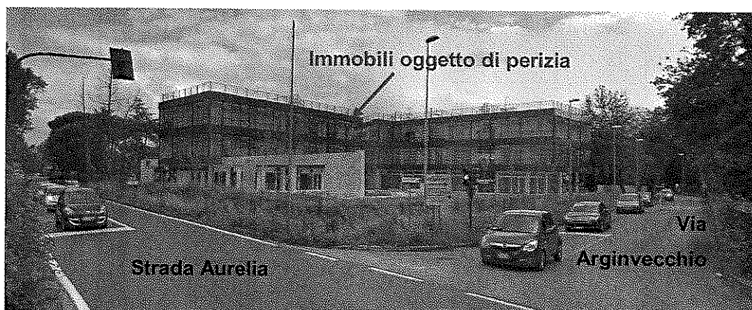
Vista del complesso – dall'angolo via Aurelia- Via Arginvecchio
