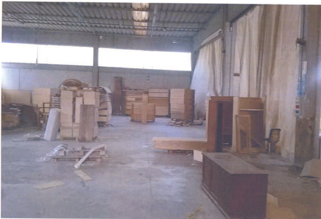
12 – VISTA DELL'INTERNO DEL FABBRICATO, ZONA ARTIGIANALE
