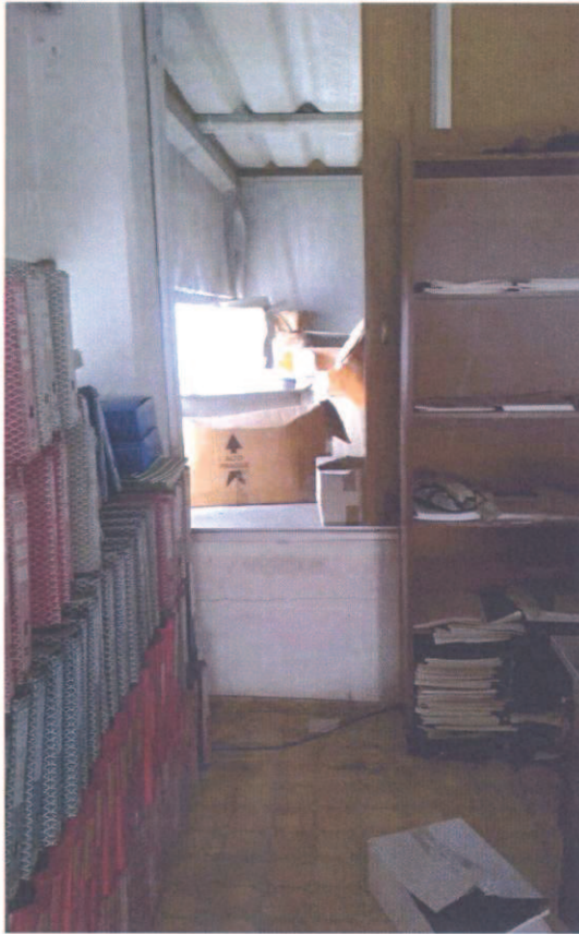
27 – VISTA DELL'INTERNO DEL FABBRICATO, ZONA UFFICI
