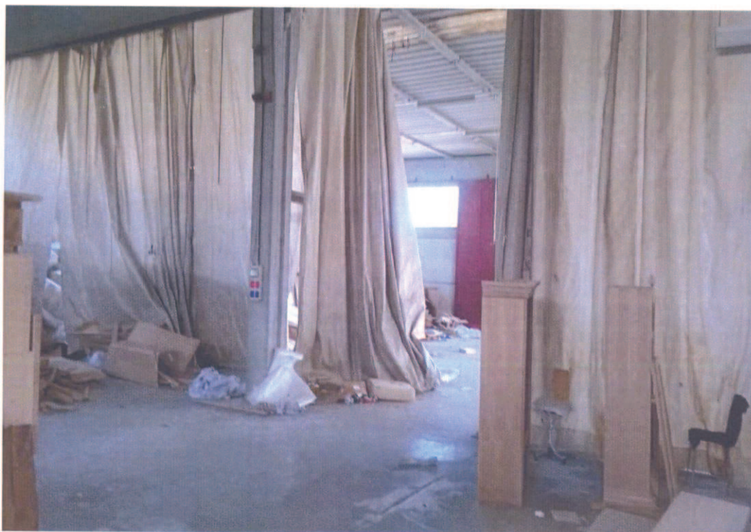
13 – VISTA DELL'INTERNO DEL FABBRICATO, ZONA ARTIGIANALE
