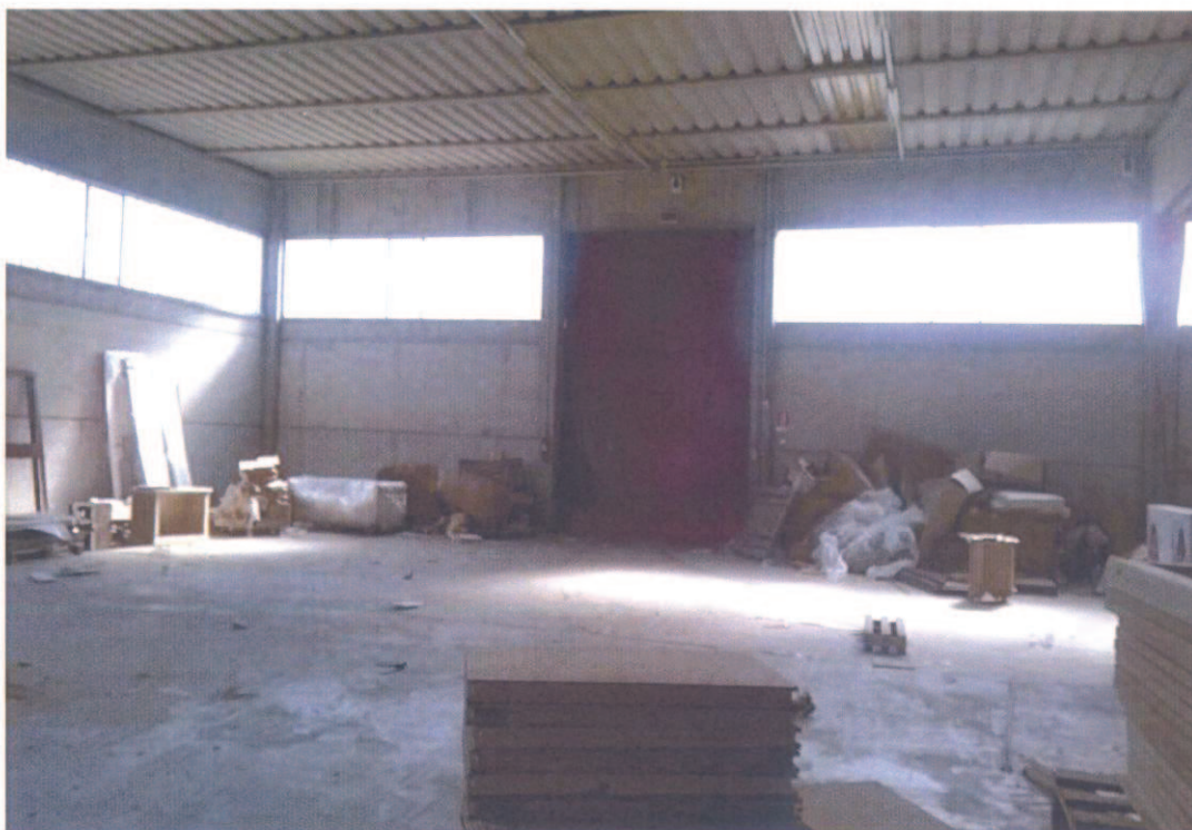
17 – VISTA DELL'INTERNO DEL FABBRICATO, ZONA ARTIGIANALE
