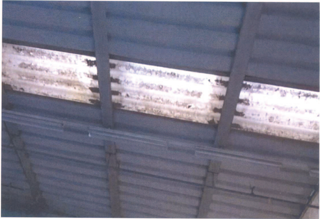
33 – VISTA DELL'INTERNO DEL FABBRICATO, COPERTURA
