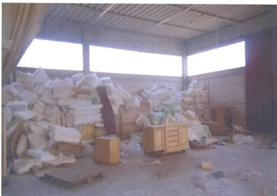
14 – VISTA DELL'INTERNO DEL FABBRICATO, ZONA ARTIGIANALE
