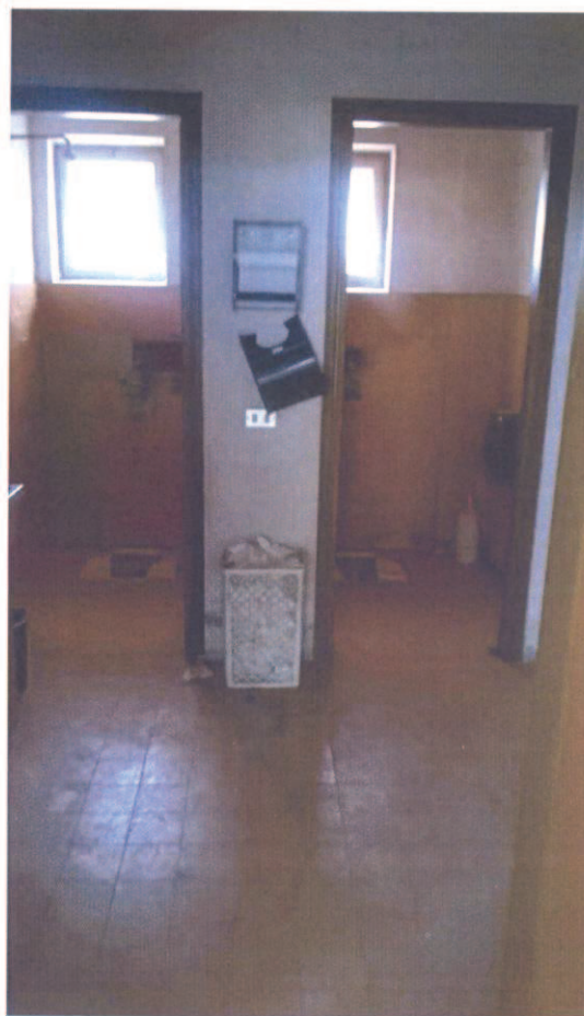
24 – VISTA DELL'INTERNO DEL FABBRICATO, ZONA UFFICI
