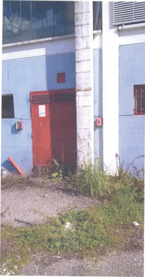
7 – VISTA INGRESSO LOCALE CENTRALE TERMICA
