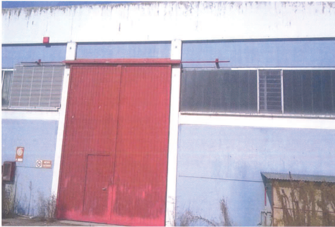
5 – VISTA DEL PORTONE E DELL' ANNESSA PORTA D'INGRESSO PEDONALE, CHE DA ACCESSO ALLA ZONA ARTIGIANALE INTERNA
