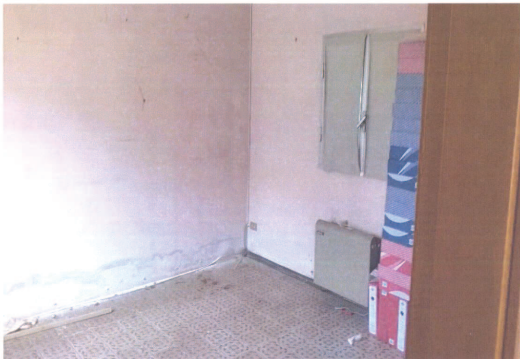
19 – VISTA DELL'INTERNO DEL FABBRICATO, ZONA UFFICI
