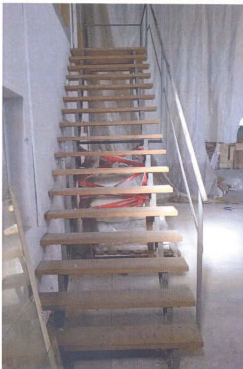
25 – VISTA DELL'INTERNO DEL FABBRICATO, SCALA ACCESSO A PIANO PRIMO
