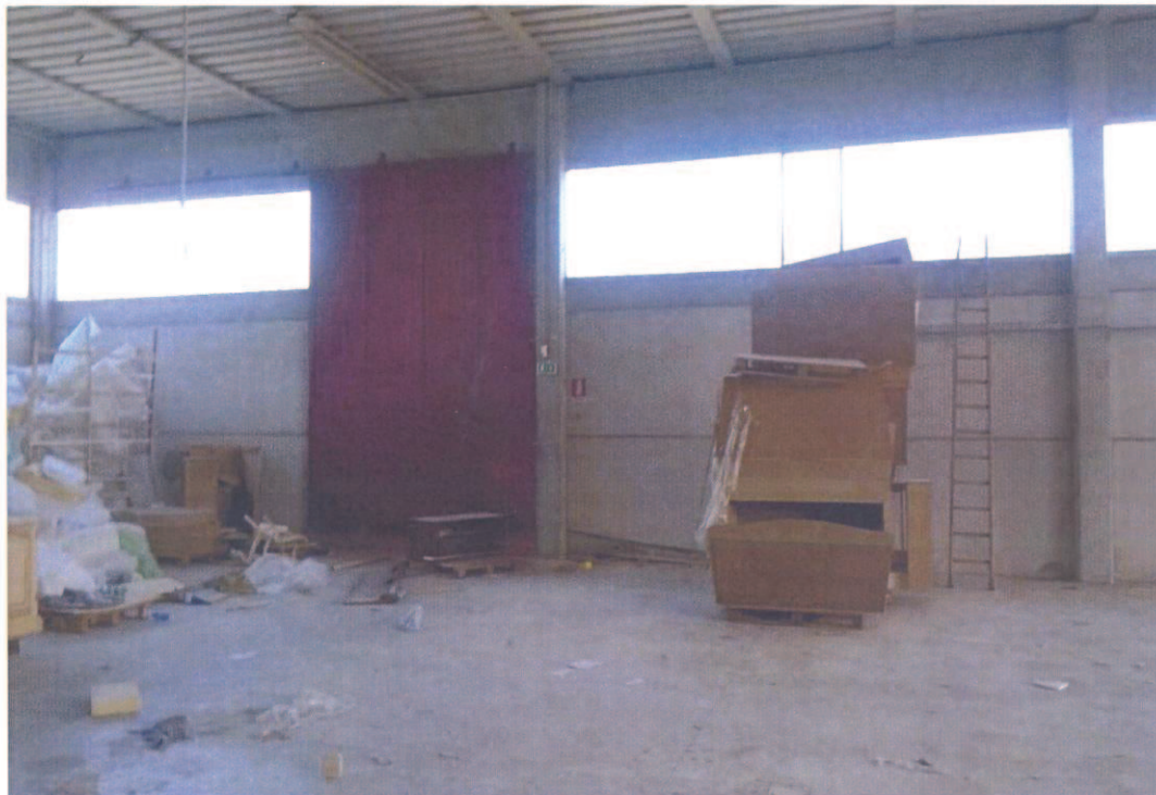
15 – VISTA DELL'INTERNO DEL FABBRICATO, ZONA ARTIGIANALE
