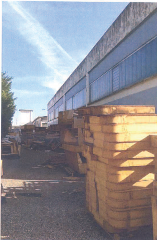
9 – VISTA DEL LATO NORD DELLA PROPRIETA'
