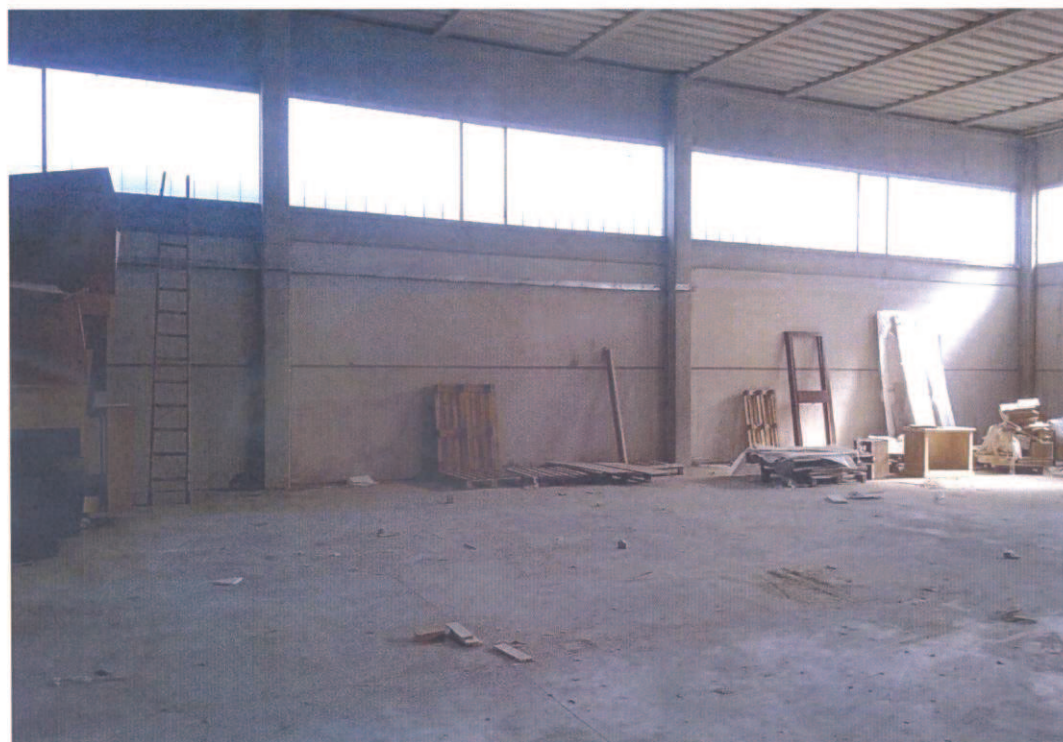
16 – VISTA DELL'INTERNO DEL FABBRICATO, ZONA ARTIGIANALE
