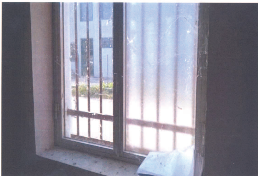
21 – VISTA DELL'INTERNO DEL FABBRICATO, ZONA UFFICI
