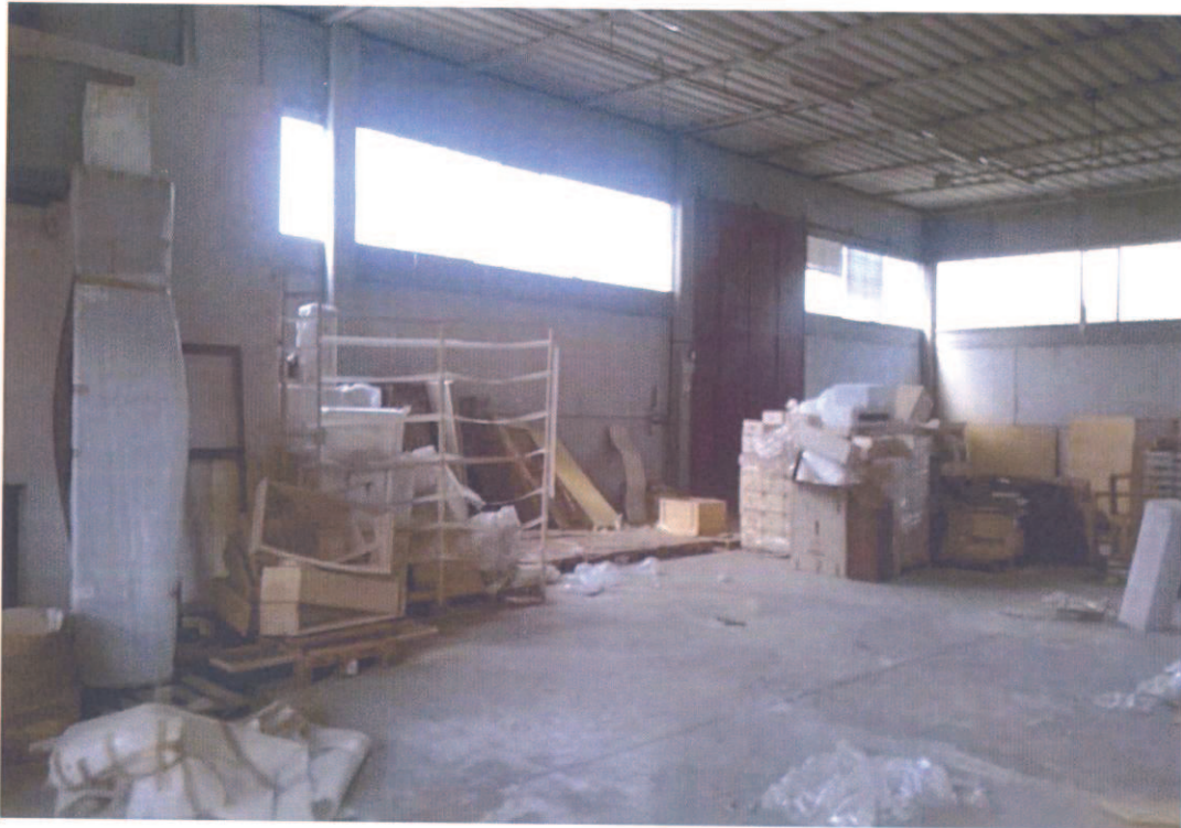
11 – VISTA DELL'INTERNO DEL FABBRICATO, ZONA ARTIGIANALE
