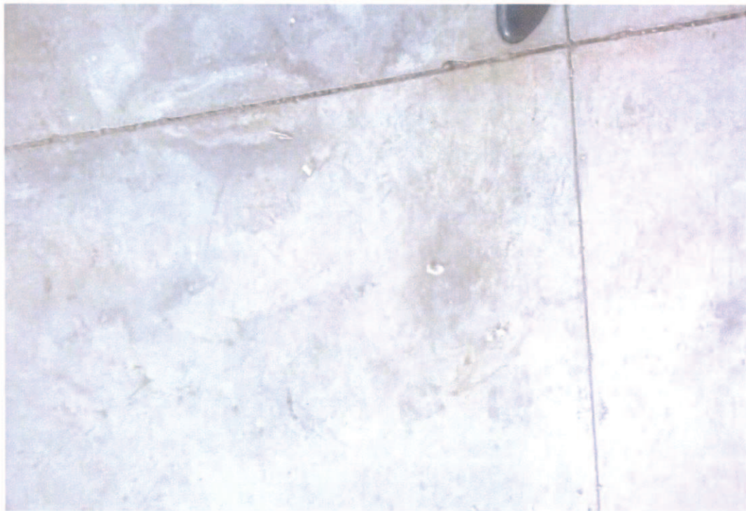
32 – VISTA DELL'INTERNO DEL FABBRICATO, PAVIMENTO MAGAZZINO
