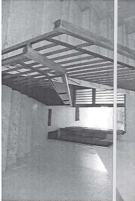
vano scale condominiale
