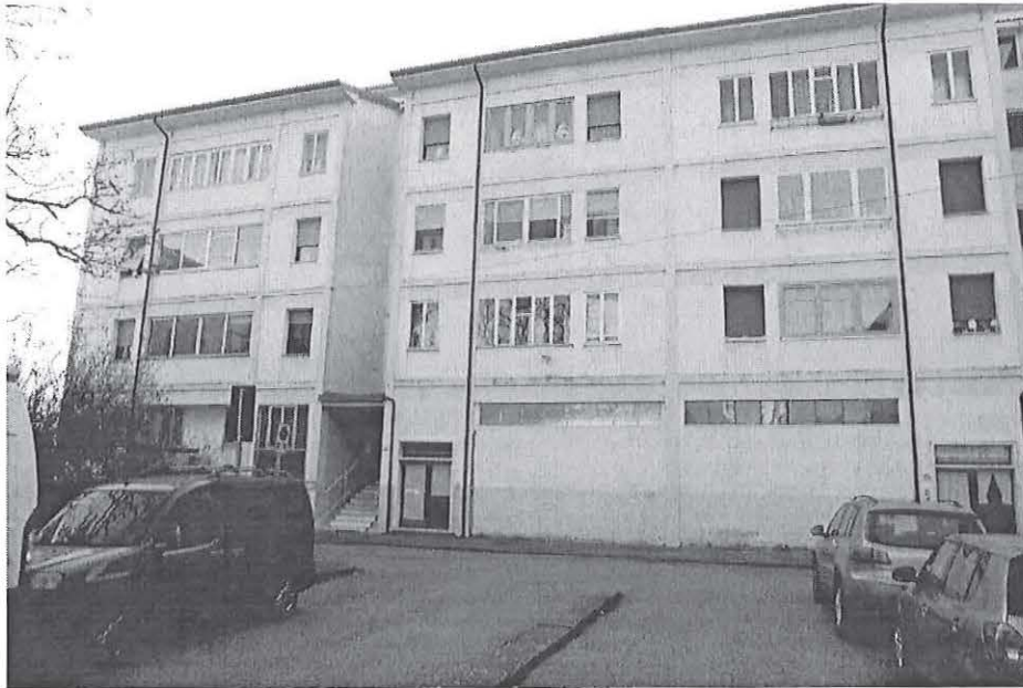
fronte principale rivolto verso nord/est
