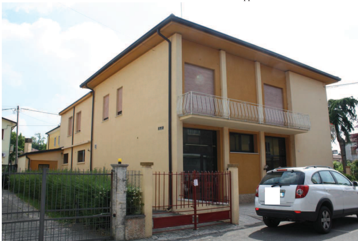
Fronte sud ovest dell'edificio su Via Cappa
