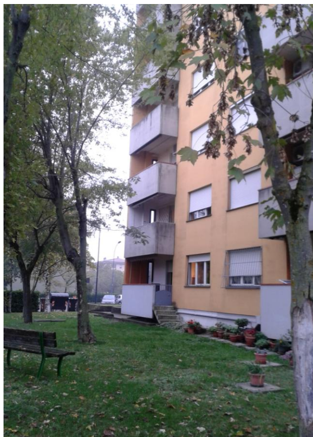
FOTO 4 – Veduta area comune fabbricato
