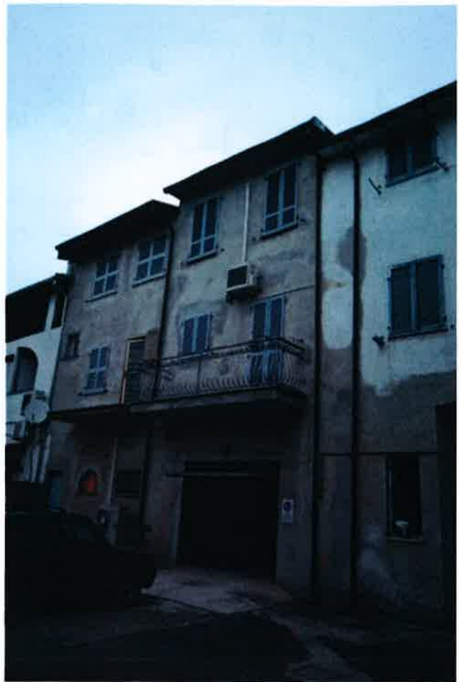
Vista della corte interna
