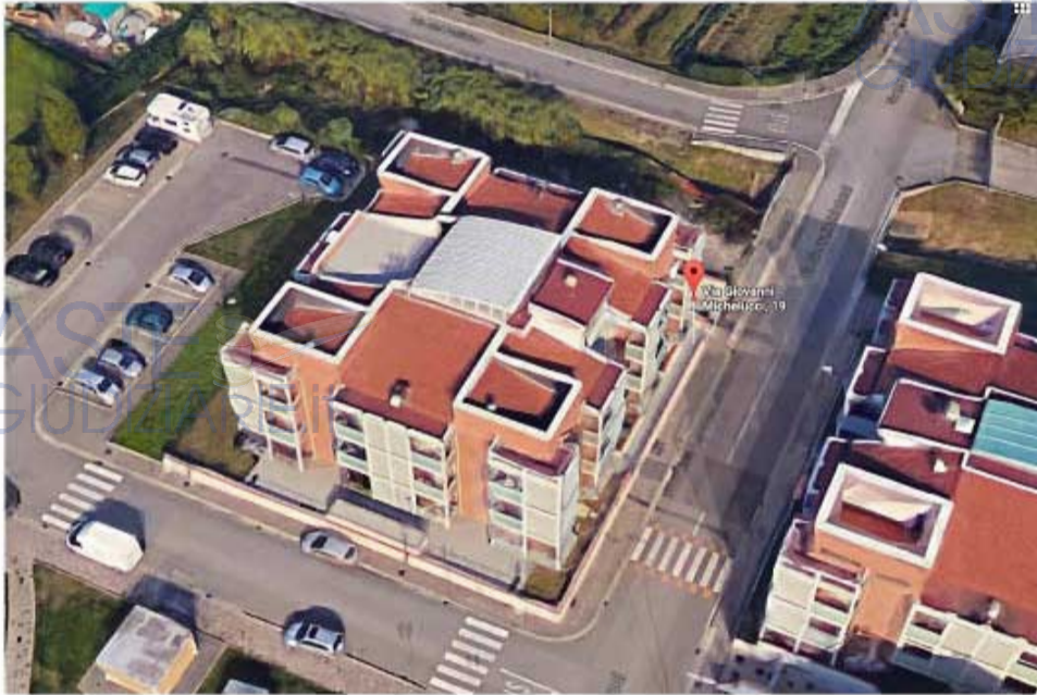
Fotografia n. 2 : vista aerea del fabbricato oggetto di stima
