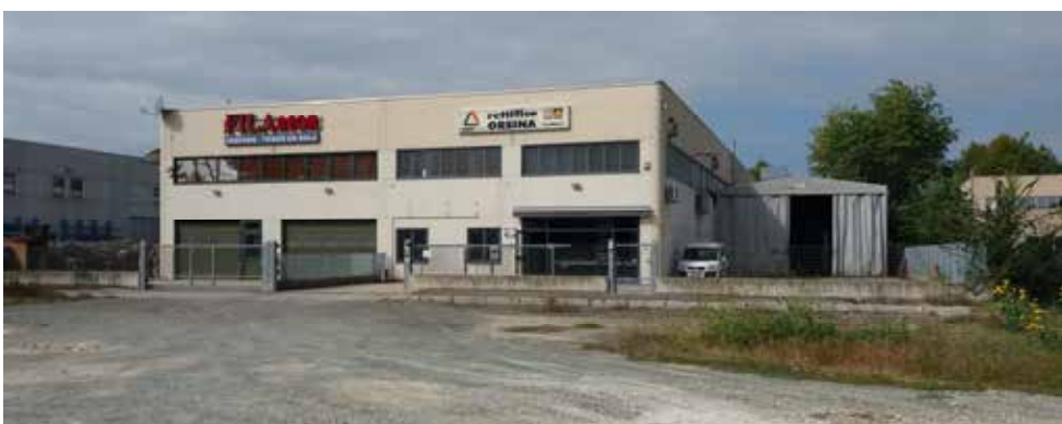
Due vedute generali del fabbricato, prospetto principale su via dell'Industria
