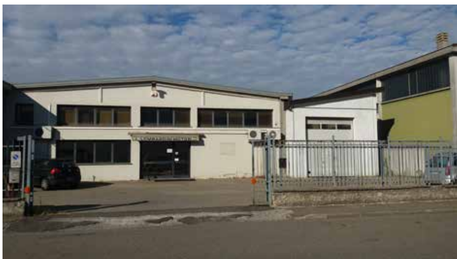
Veduta esterna dell'unità di cui al punto B.1.1.B
