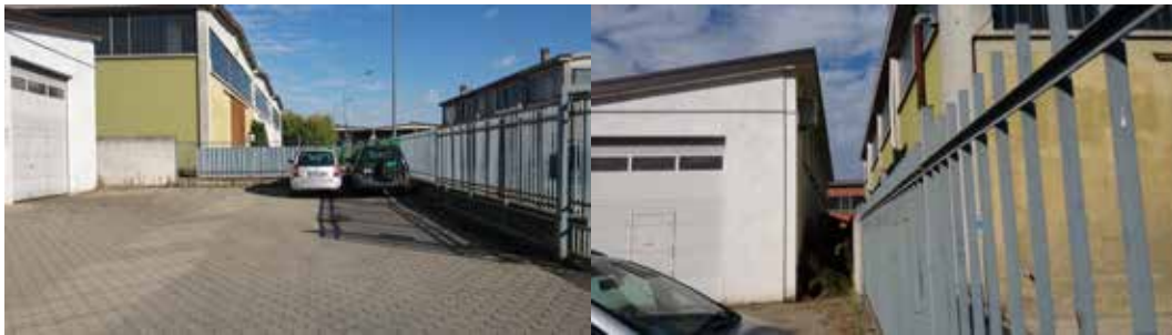
Vedute esterne dell'unità di cui al punto B.1.1.B, in particolare del corpo aggiunto a est
