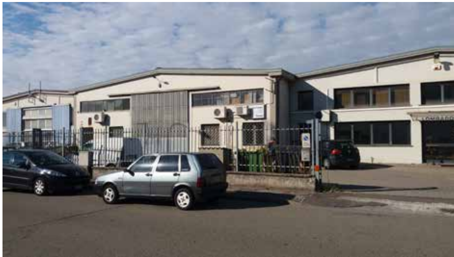
Veduta esterna dell'unità di cui al punto B.1.1.A; sulla destra, uno scorcio dell'unità di cui al punto B.1.1.B
