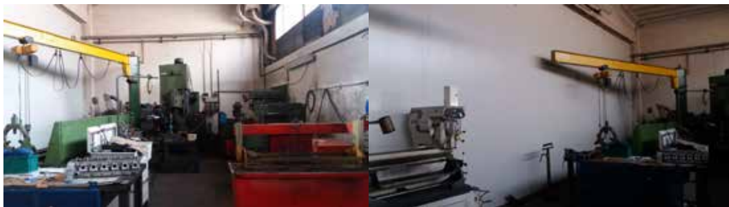
Vedute interne dell'unità di cui al punto B.1.1.A (officina meccanica)
