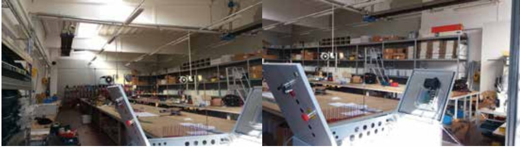
Vedute interne dell'unità di cui al punto B.1.1.A (officina meccanica, porzione data in locazione)
