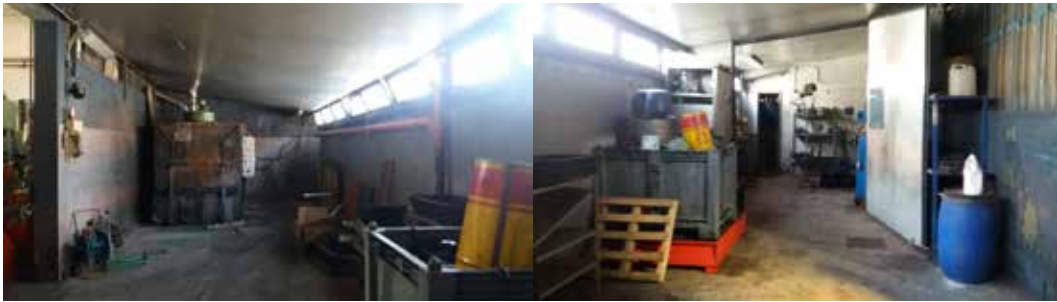
Vedute interne dell'unità di cui al punto B.1.1.A (tettoia sul lato nord)
