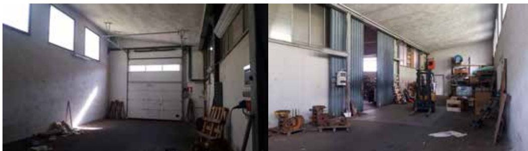
Vedute interne dell'unità di cui al punto B.1.1.A (officina meccanica, corpo aggiunto a est)
