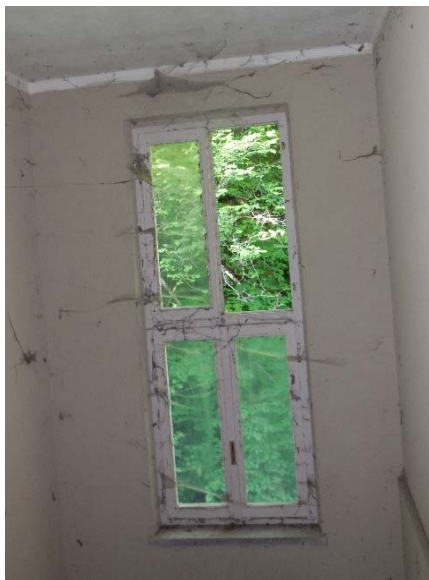
Figura 6 – PARTICOLARE SERRAMENTO TIPO
