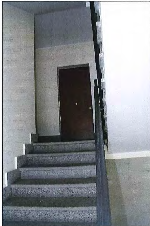
Porta di ingresso per ogni singola abitazione
