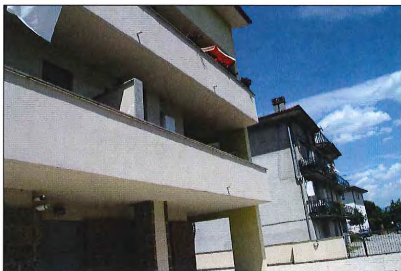
Facciata esterna del palazzo con balconi
