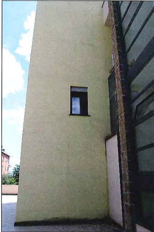
Facciata esterna del palazzo
