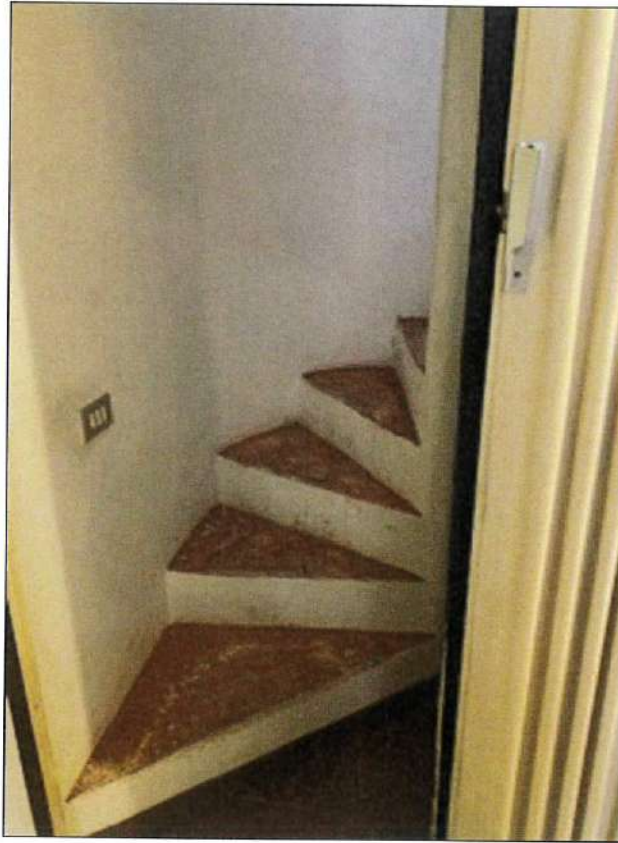
SCALA DI ACCESSO AL PIANO SOTTOTETTO
