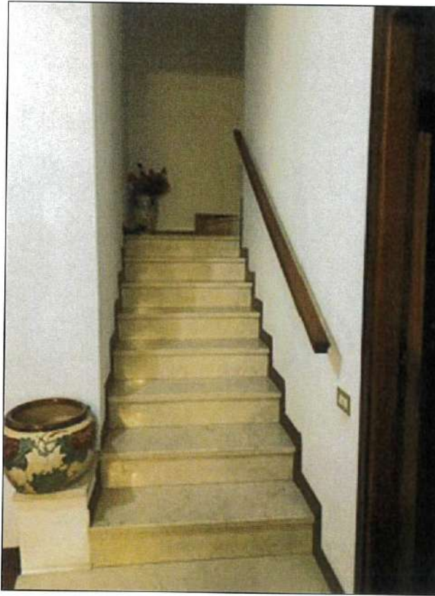
SCALA DI ACCESSO AL PIANO PRIMO
