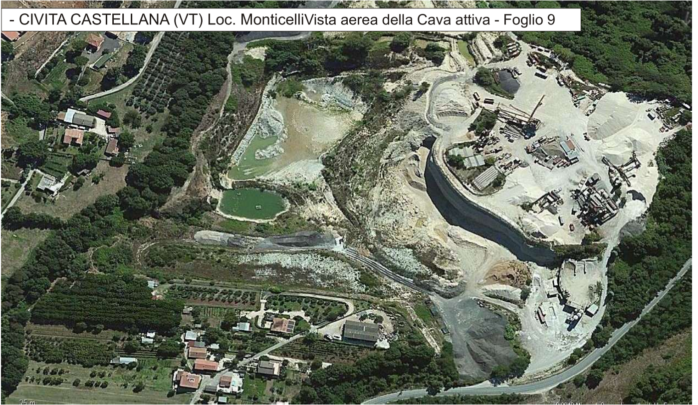
- CIVITA CASTELLANA (VT) Loc. Monticelli Vista aerea inquadramento generale
