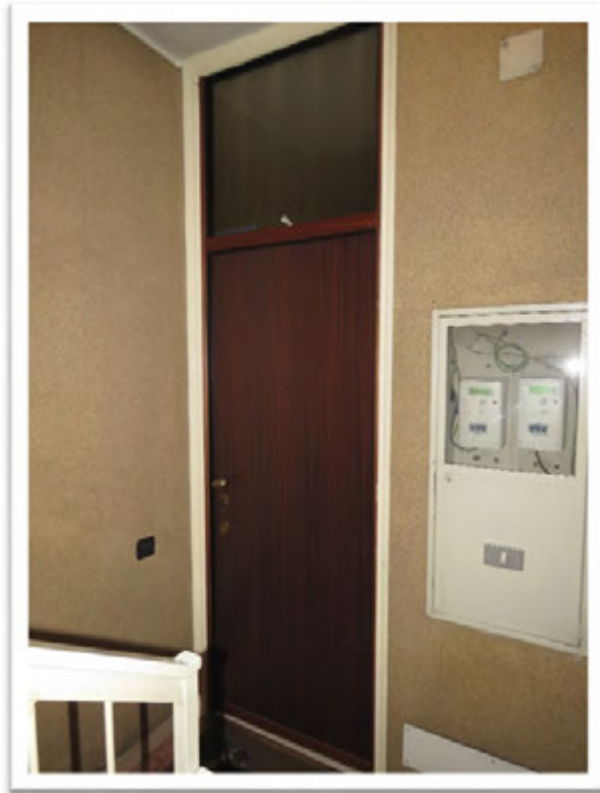
Particolare interno ed esterno dell'ingresso all'alloggio.
