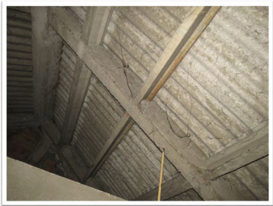
Particolare della copertura in Eternit.
