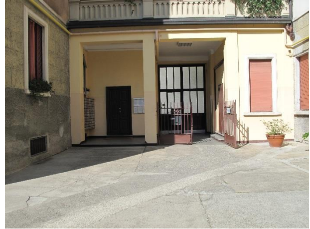
esterno fabbricato verso corte – zona ingresso
