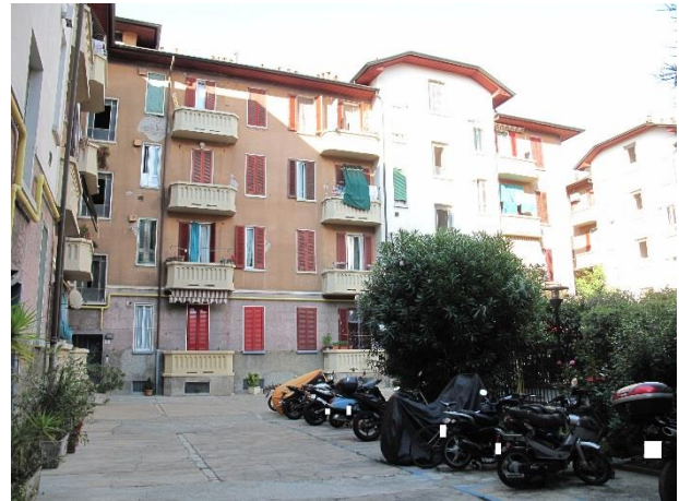
esterno fabbricato verso corte
