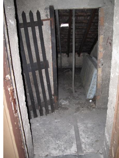
esterno solaio – zona ingresso
