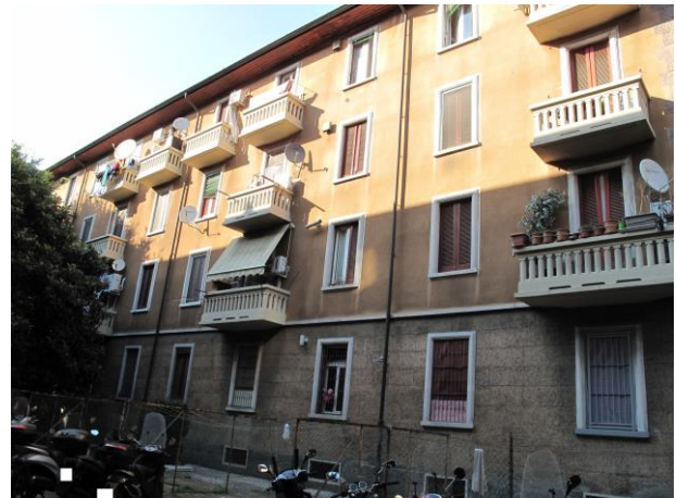
esterno fabbricato verso area retrostante (con scala "E") ed esterno appartamento
