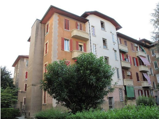
esterno fabbricato verso corte (con scala "E")
