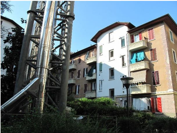
esterno fabbricato verso corte
