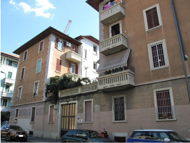
esterno fabbricato verso via De Predis
