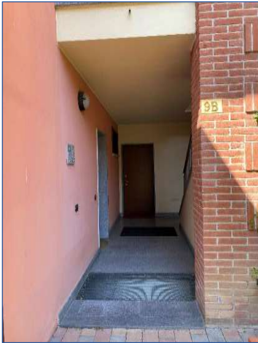
Foto 9 - ingresso edificio 9 - scala B
