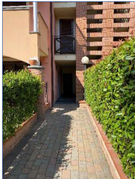
Foto 8 - ingresso edificio 9 - scala B
