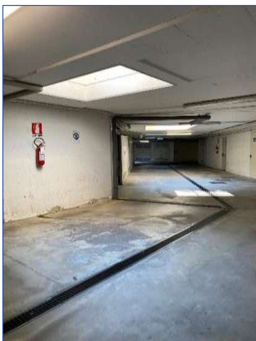
Foto 19 - corsello di manovra comune piano S1
