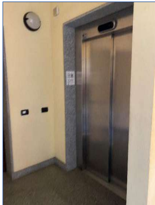
Foto 12 - vano ascensore comune
