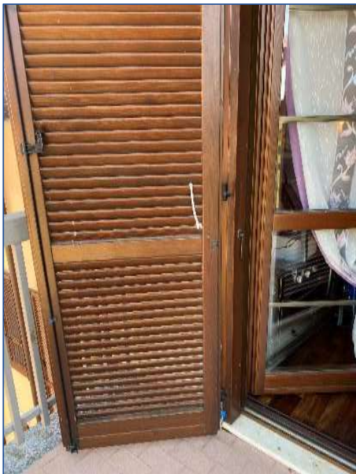
Foto 47 - dettaglio serramento esterno
