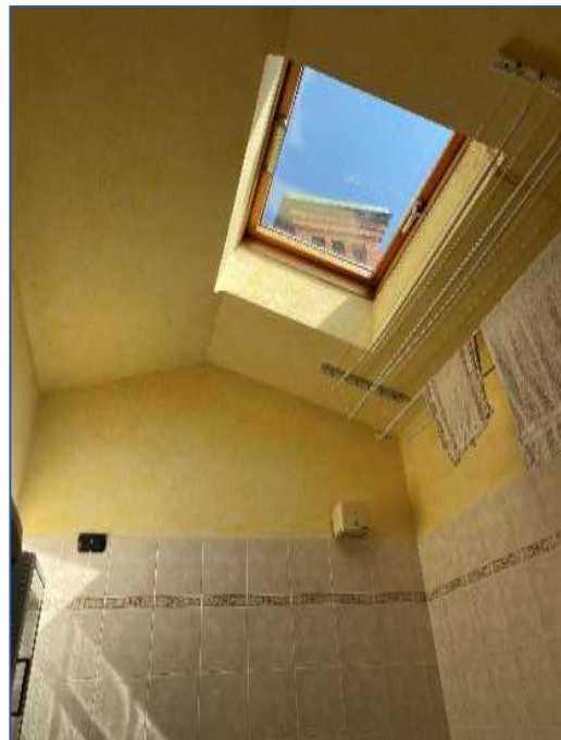
Foto 40 - dettaglio lucernario bagno 1
