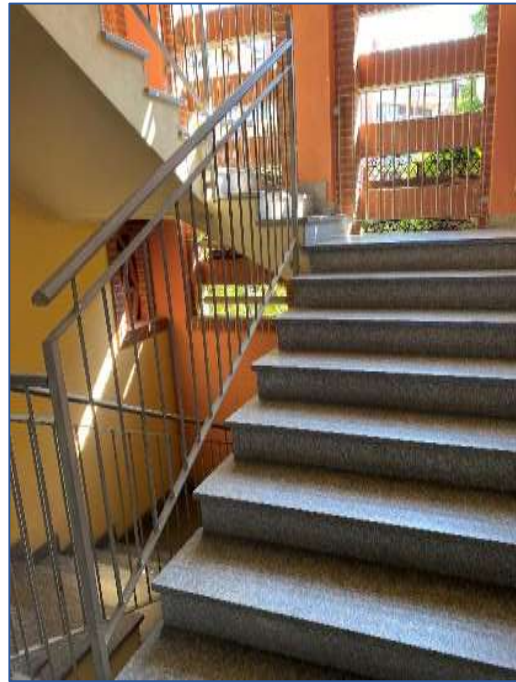
Foto 10 - vano scala comune
