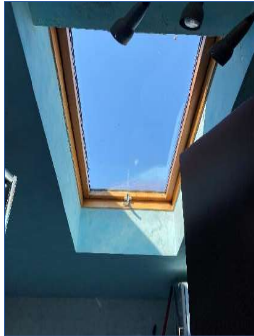
Foto 44 - dettaglio lucernario bagno 1
