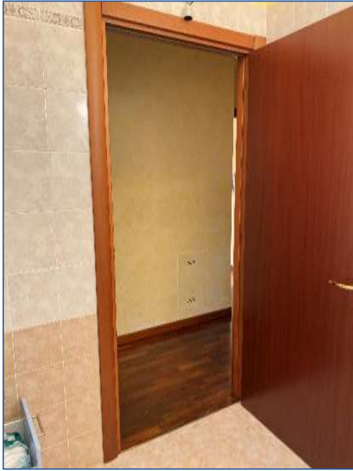
Foto 41 - dettaglio serramento bagno 1
