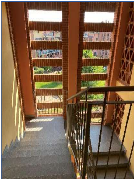
Foto 11 - vano scala comune
