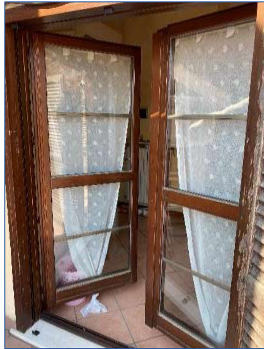
Foto 46 - dettaglio serramento esterno
