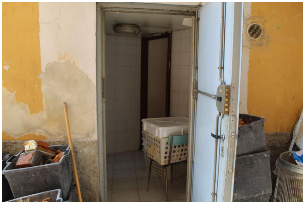
FOTO 10: MILANO, VIA PADOVA 82, uscita dal disimpegno in cortile comune
