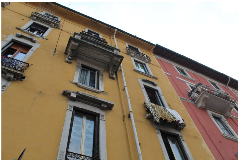
FOTO 2: MILANO, VIA PADOVA 82, fronte civico 82
