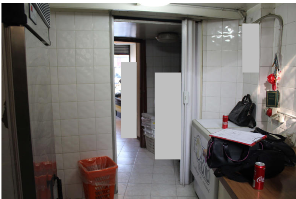
FOTO 8: MILANO, VIA PADOVA 82, retro vista verso disimpegno e negozio
