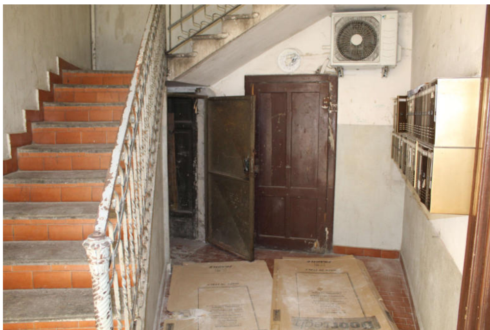
FOTO 12: MILANO, VIA PADOVA 82, ingresso comune piano cantine civico 82
