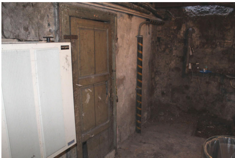
FOTO 13: MILANO, VIA PADOVA 82, porta ingresso cantina
