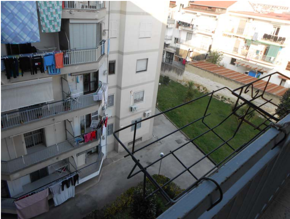
Foto n. 17: Vista corte condominiale dal balcone
