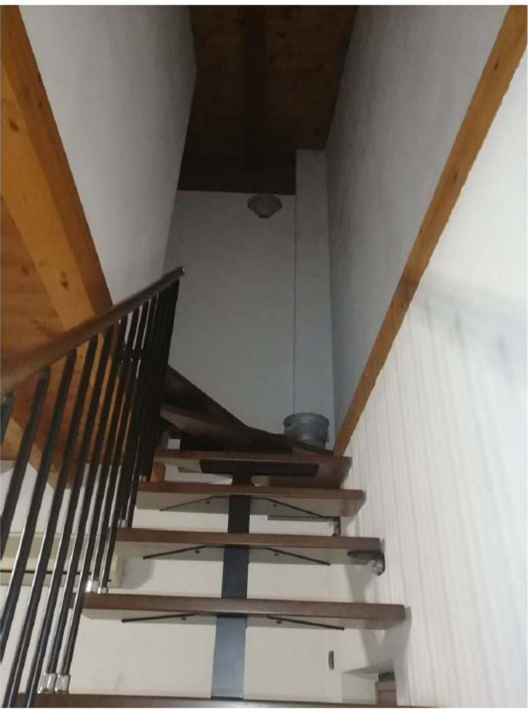
Scala accesso sottotetto
