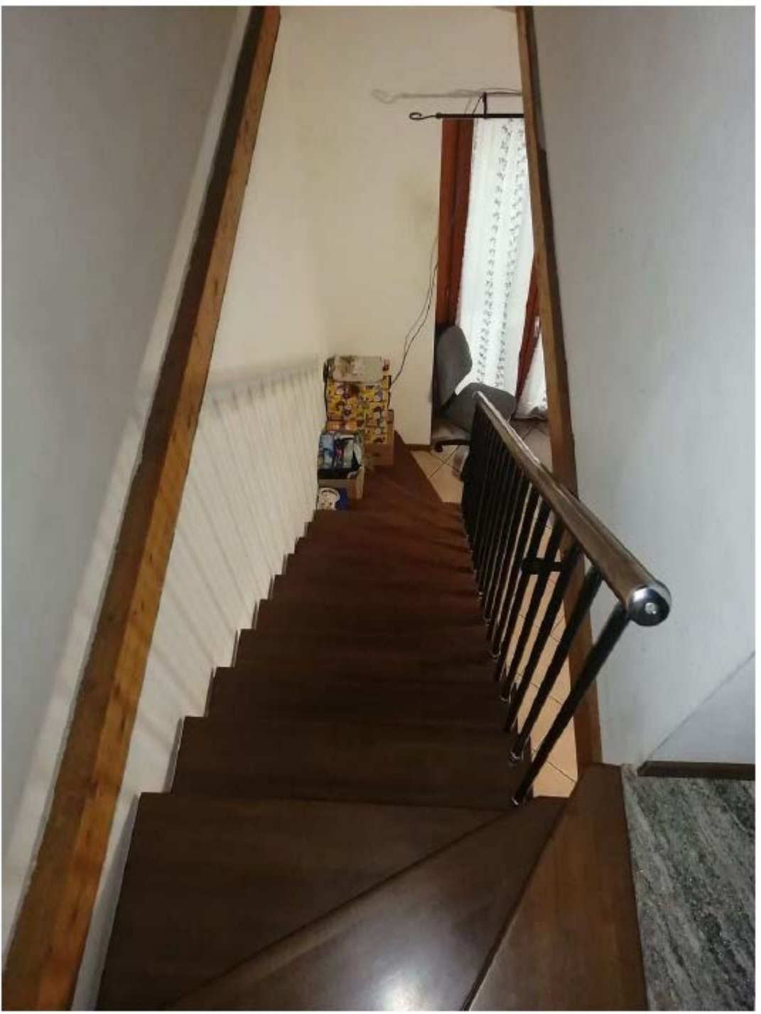
Scala accesso sottotetto
