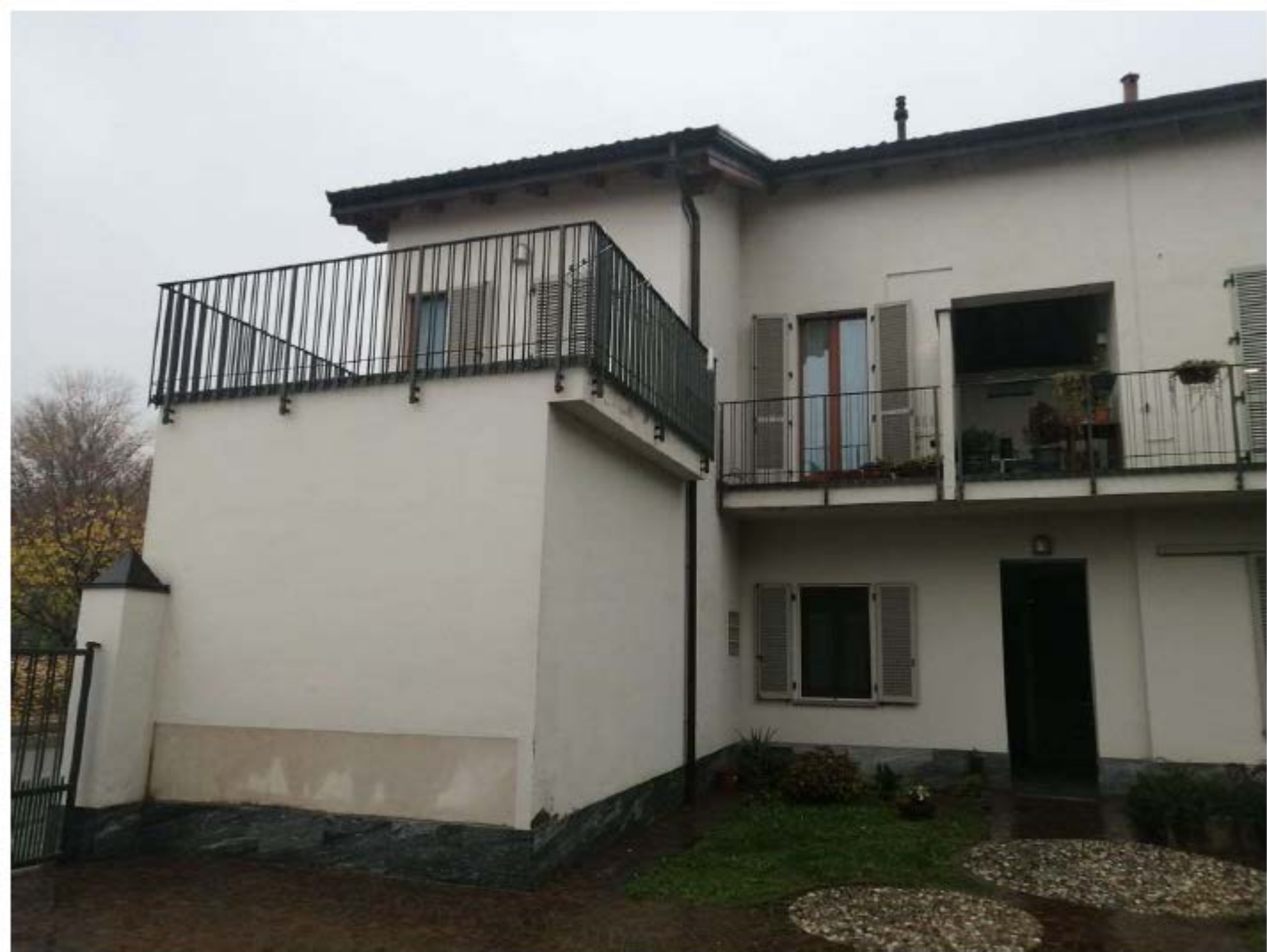
Vista dell immobile cortile condominiale
