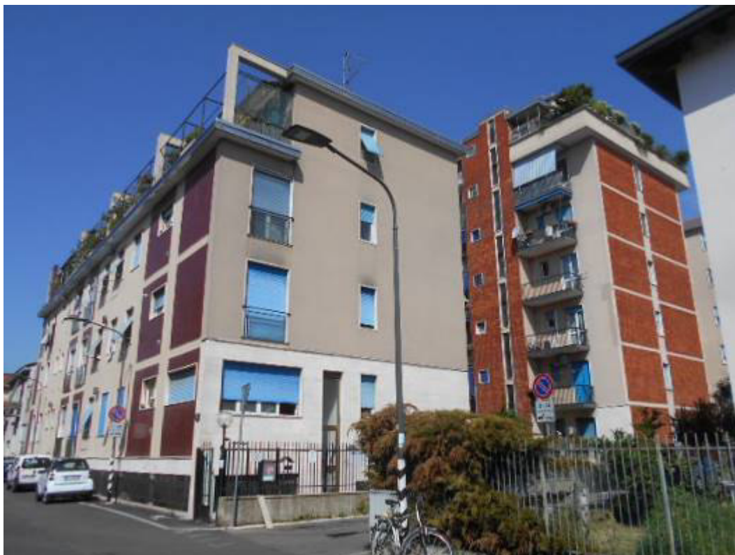
FOTO 3 – Dettaglio della fronte in affaccio sulla Via Capri angolo via Privata
