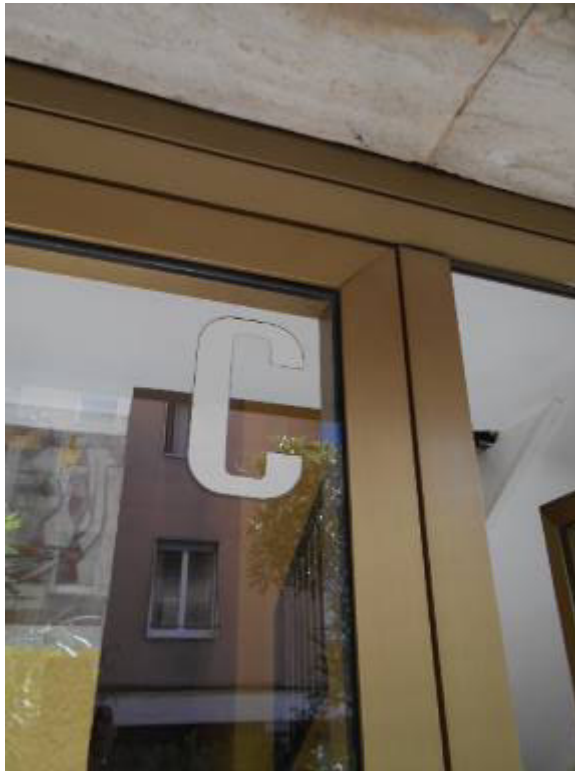
FOTO 6 – Dettaglio del scala C
