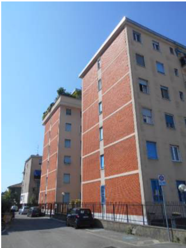
FOTO 7 – Dettaglio del fronte est
