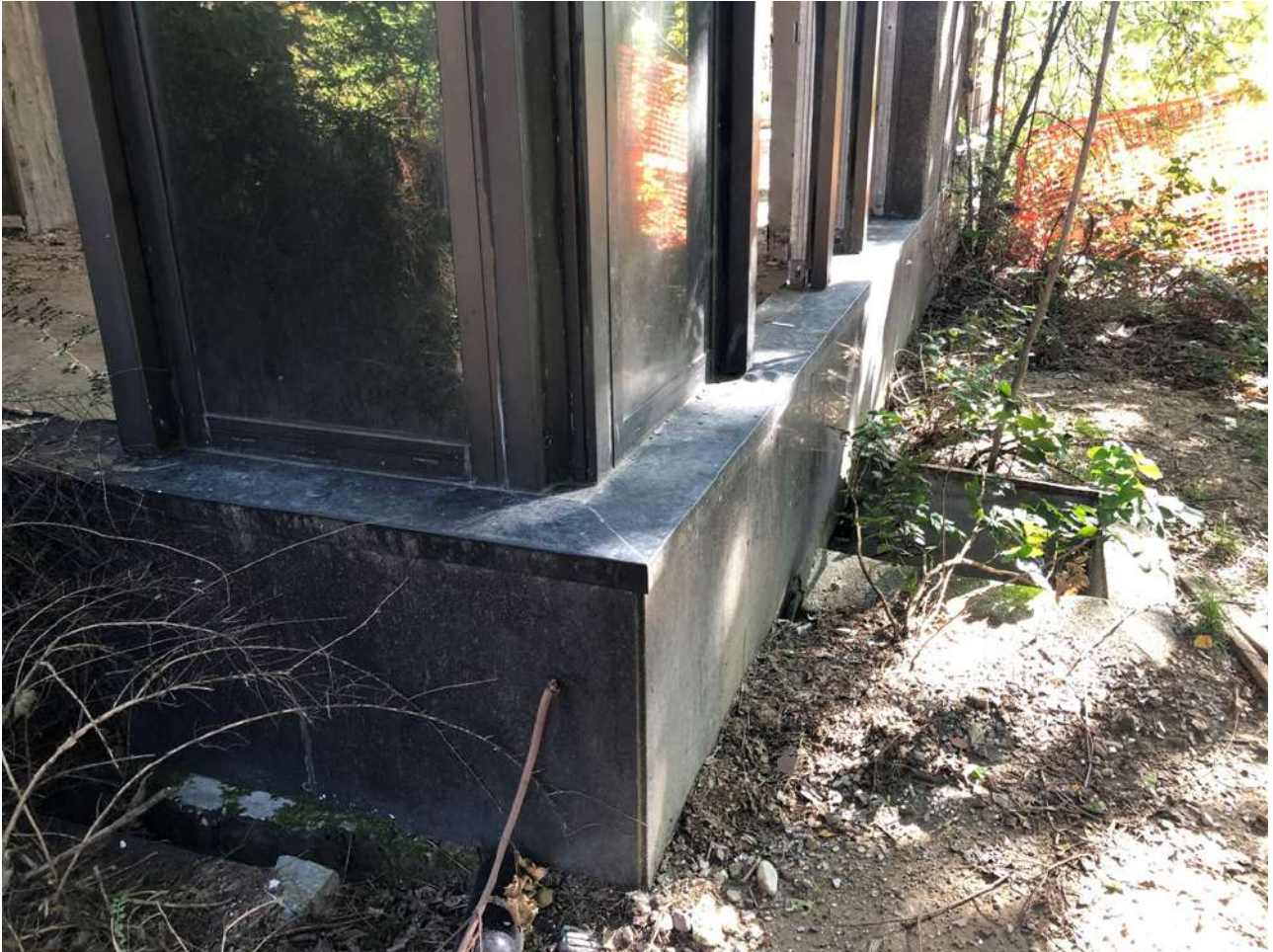
Dettaglio zoccolo edificio
