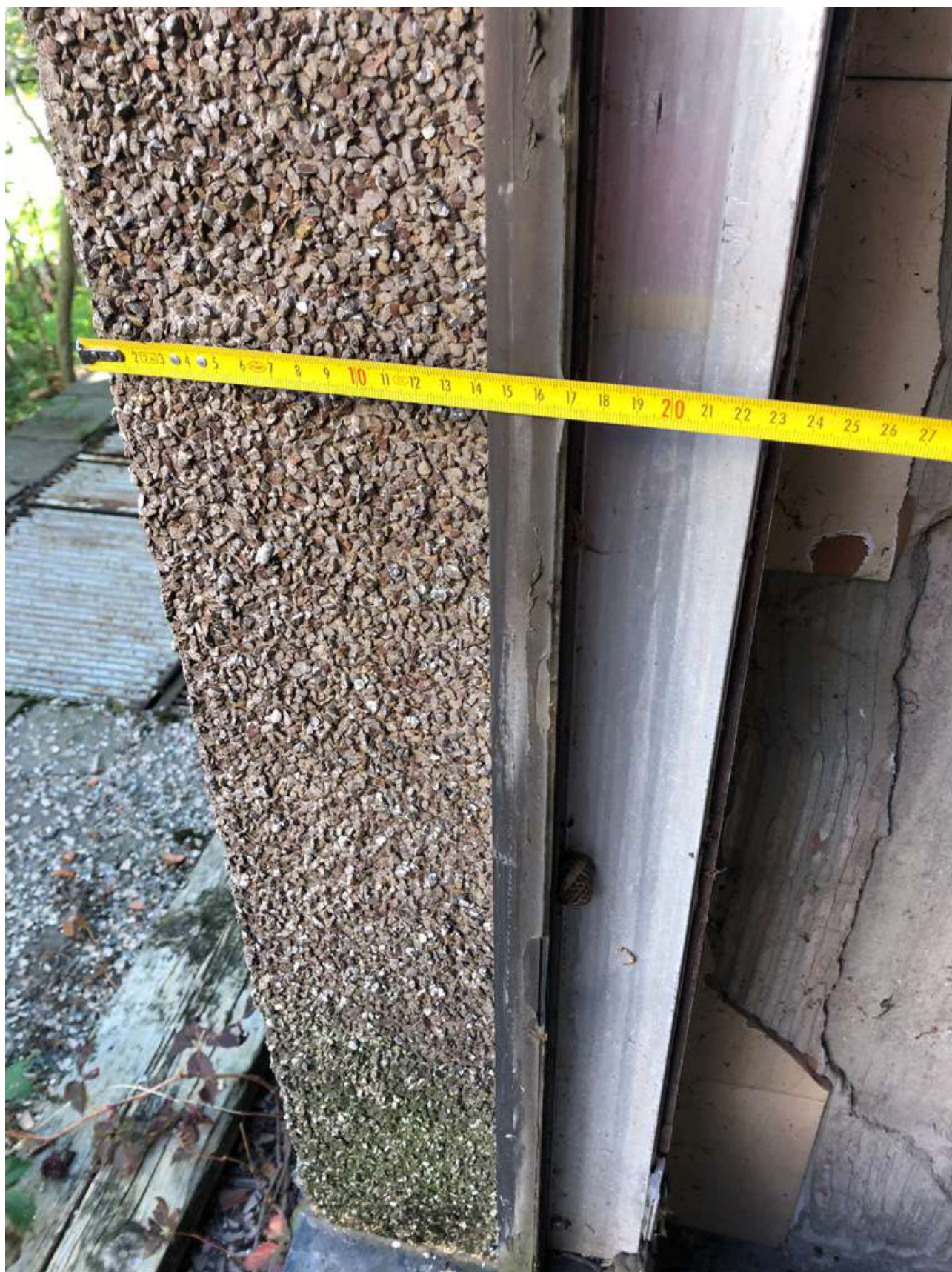
Dettaglio infisso piano terra
