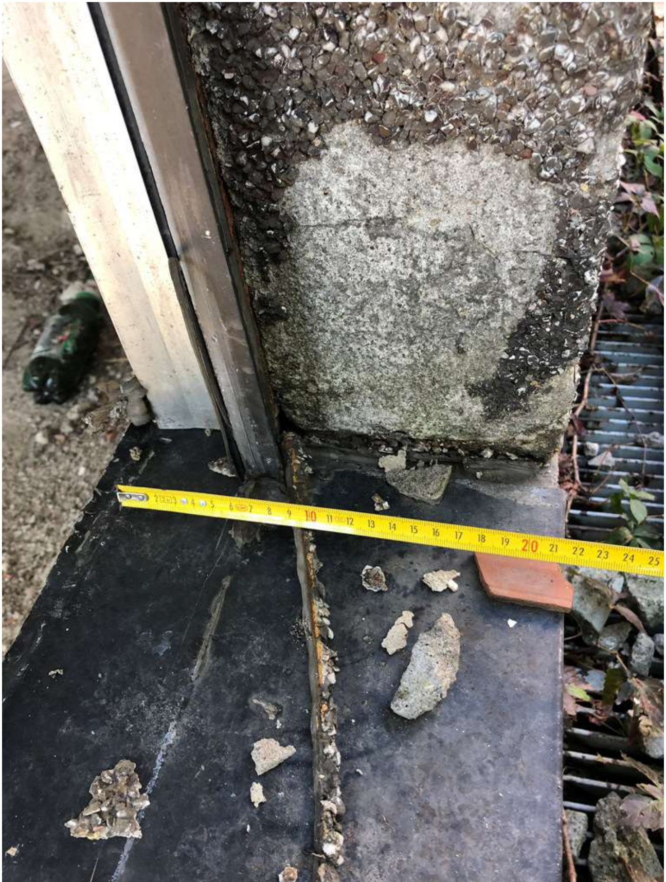
Dettaglio infisso piano terra
