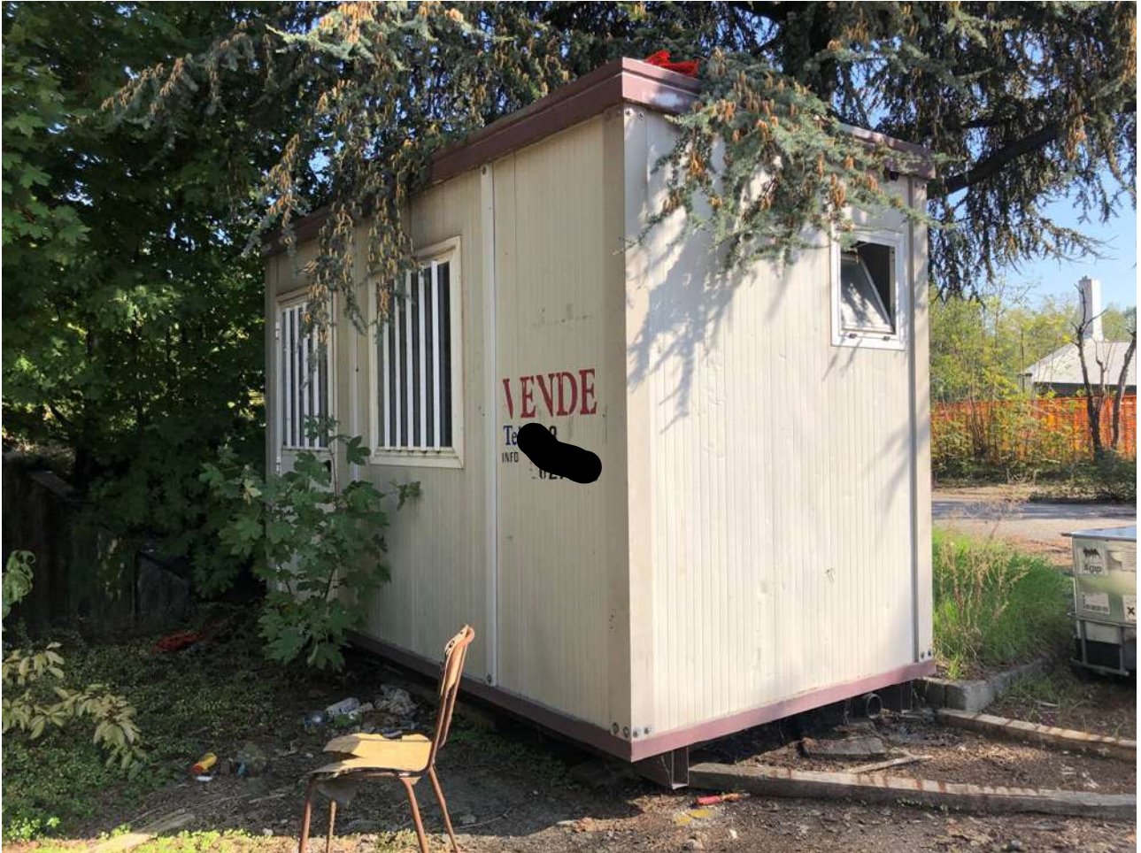
Baracca di cantiere
