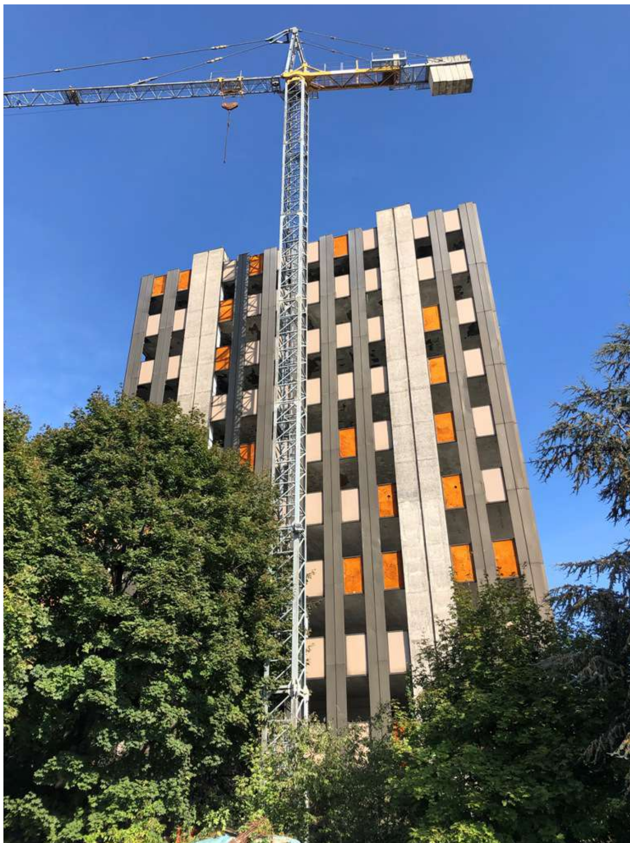
Edificio vista facciata ovest
