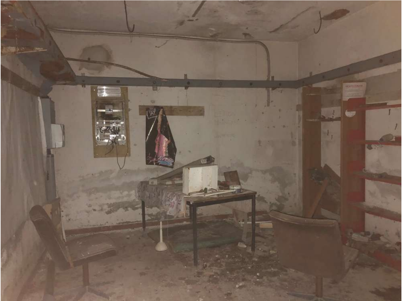
Locale contatori e dettaglio rampa accesso a deposito
