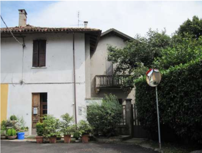
vista della porzione semindipendente 2014
