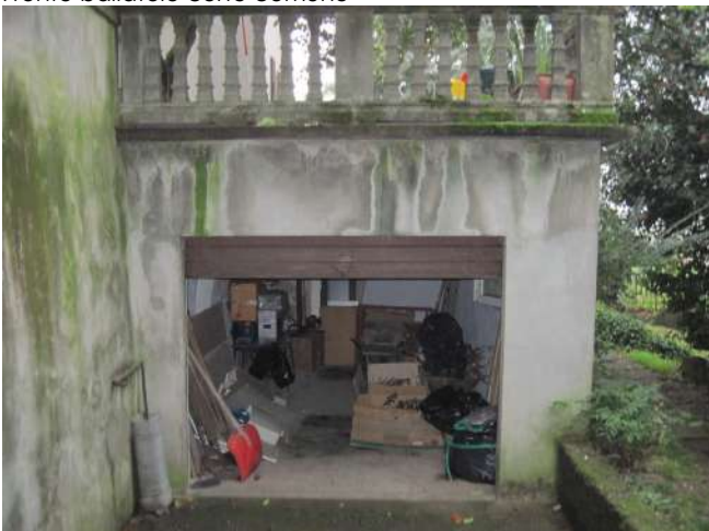
condizioni delle facciate (particolare)2014
