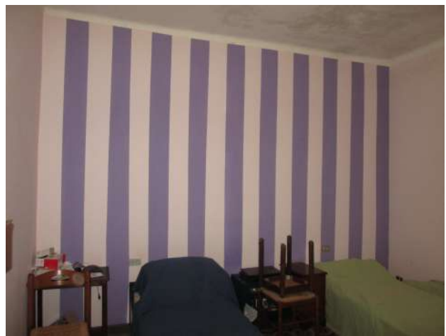
2021 ammaloramento dei solaio a copertura
