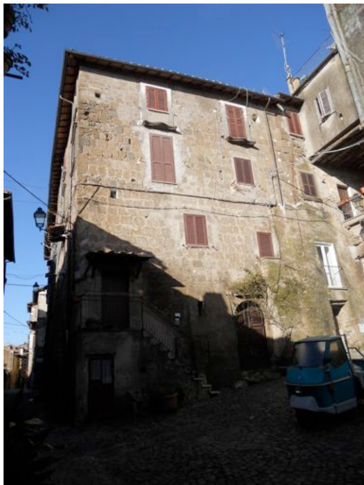
FOTO 24 Prospetto su Piazza Casalino angolo via Orioli
