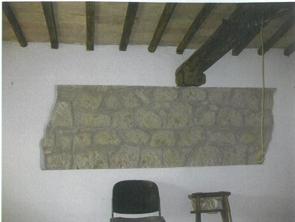
Fotografia 6 – PARTICOLARE INSERTO IN PIETRA SU PARETE SOGGIORNO
