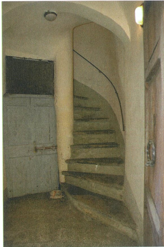
Fotografia 3 – VANO SCALA D'ACCESSO ALL'IMMOBILE STAGITO
