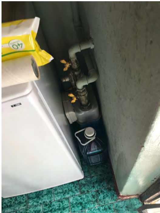
Immagini 23 e 24. Dettaglio della collocazione di contatore del gas e scaldabagno collocati all'interno della cucina.
