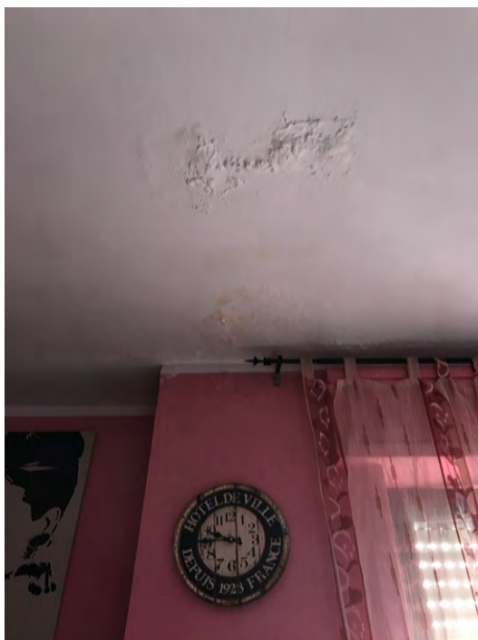
Immagini 27,28 e 29. Dettagli dei problemi interni all'unità immobiliari derivanti dalle infiltrazioni d'acqua dal piano soprastante.
