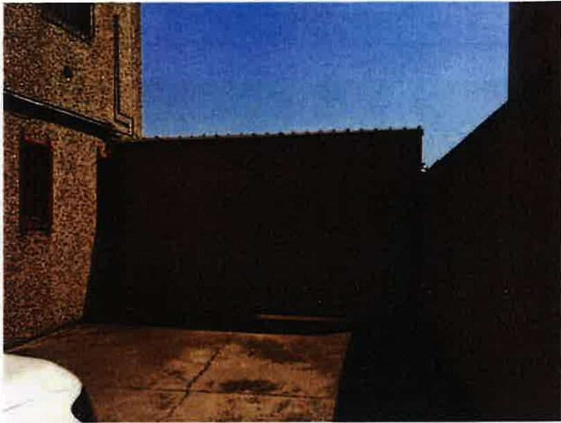
3) tettoia / box da demolire
