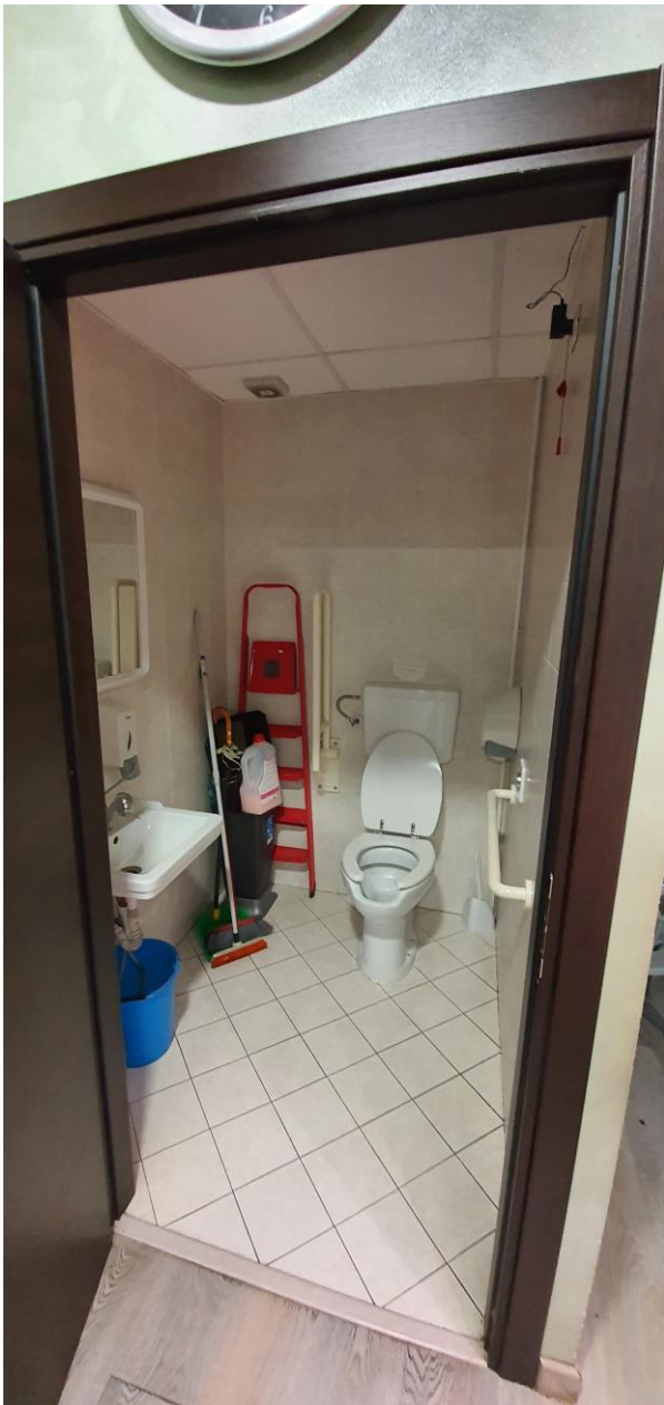
Foto n. 4 bagno locale commerciale
