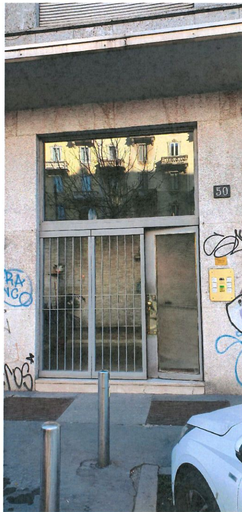
Foto 2 – Portone di accesso al fabbricato
