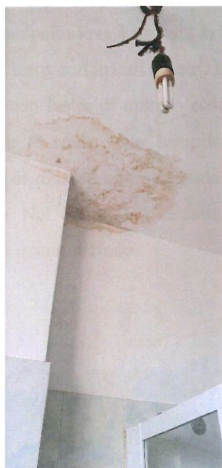
Foto 21/22/23/24/25 – Bagno – Particolare macchia di umidità nel soffitto
