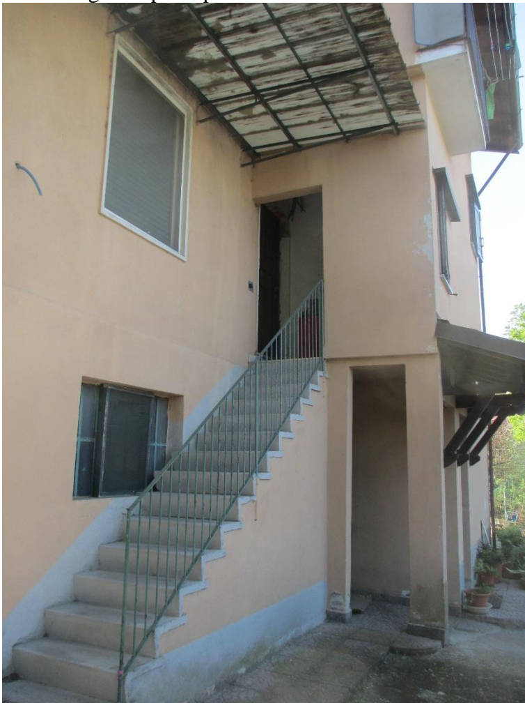
Foto 4: da cortile interno piano interrato
