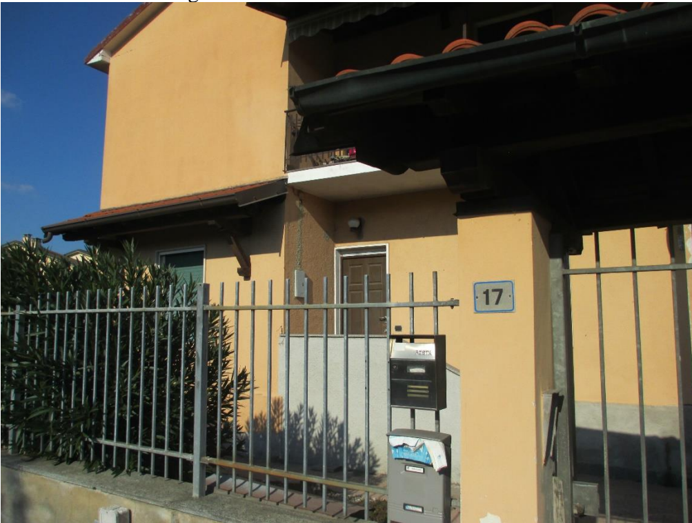
Foto 2: esterno da ingresso pedonale
