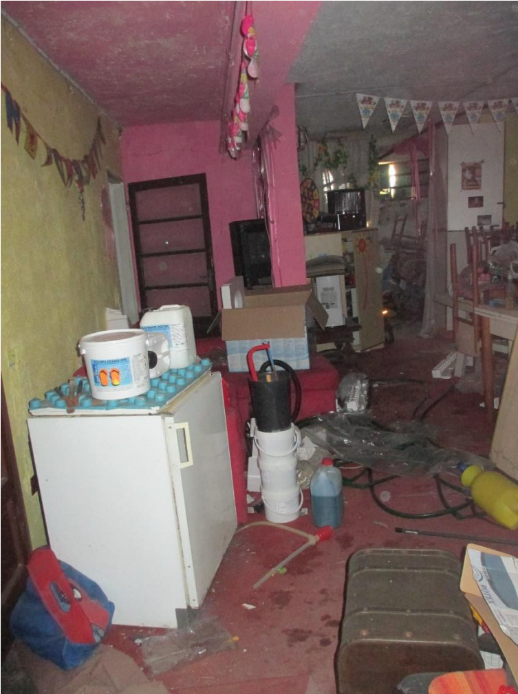
Foto 17: cantina locale principale
