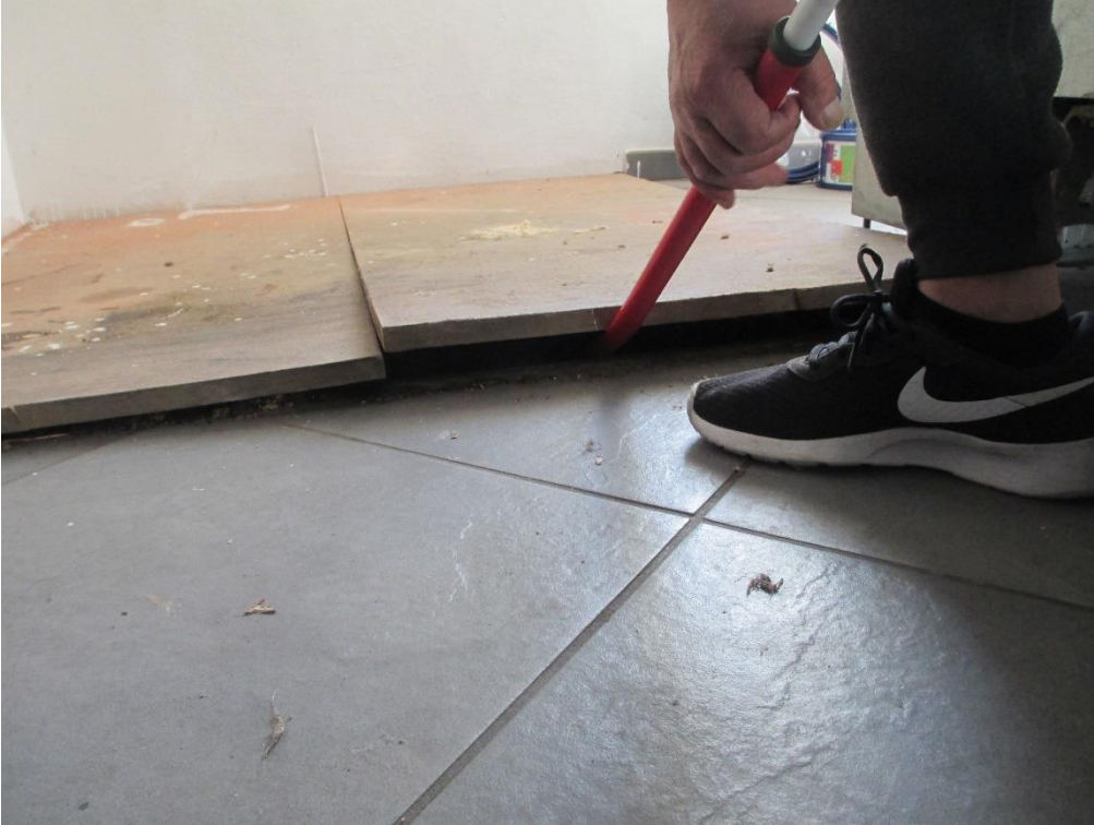
Foto 15: chiusura foro di collegamento con piano cantina
