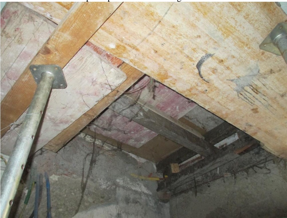
Foto 22: puntellatura foro vano scala
