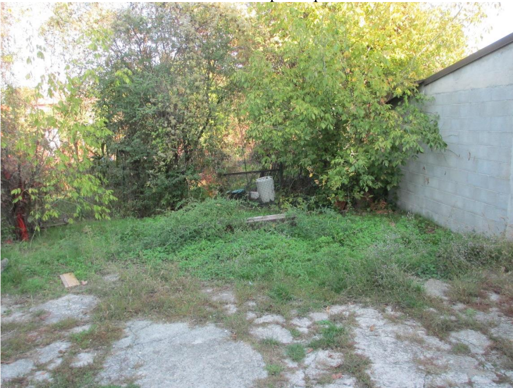
Foto 26: area cortilizia dove prima sorgeva locale ripostiglio demolito senza autorizzazione
