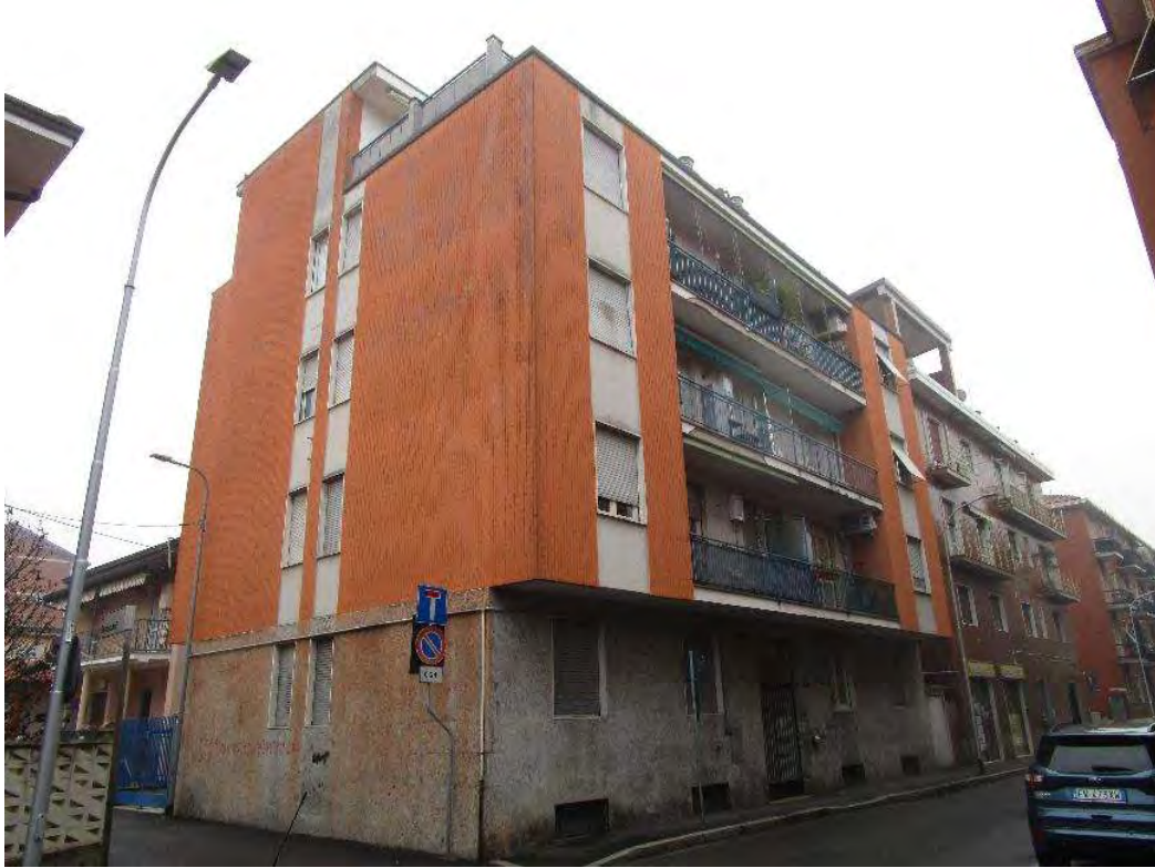
1. Condominio di Via Galileo Galilei 14, vista lato nord-ovest.
