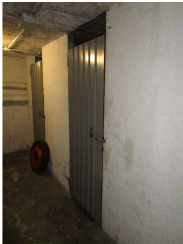
25. Porta di accesso alla cantina.
