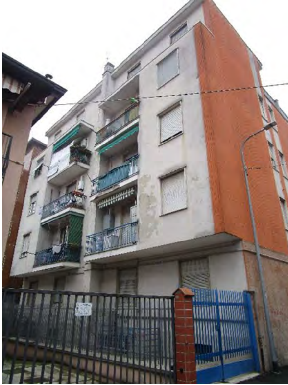
3. Fabbricato, vista lato est.
