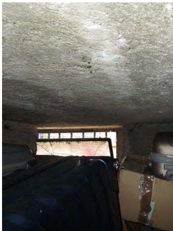
27. Vano finestrato in cantina.
