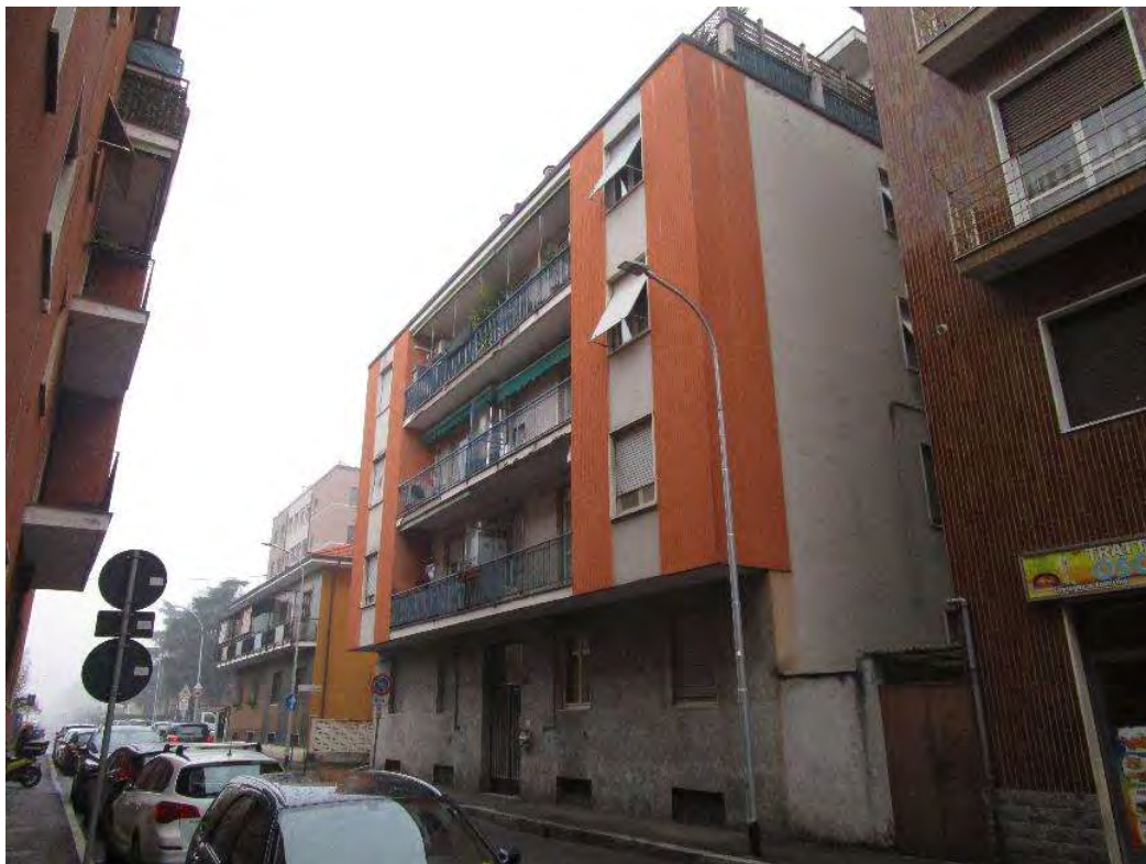
2. Condominio di Via Galileo Galilei 14, vista lato sud-ovest.
