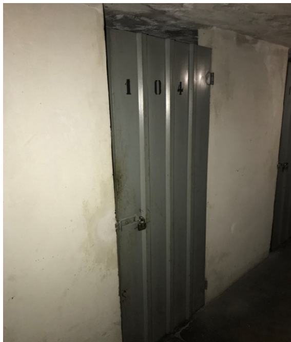
Foto n.9: Solaio - Piano sottotetto.
