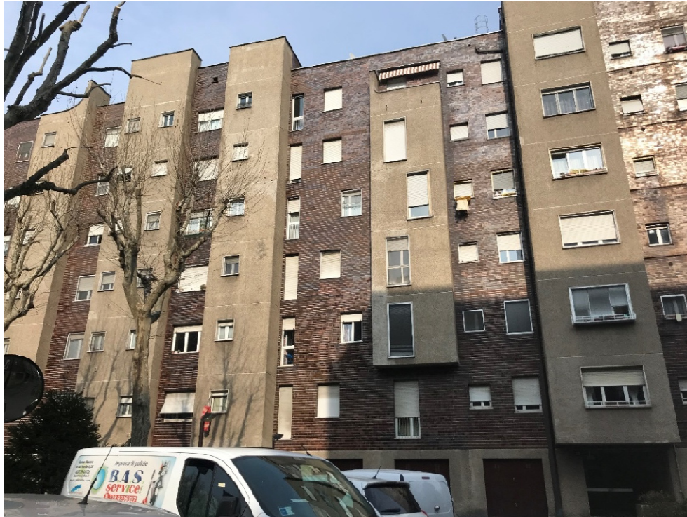
Foto n. 1: Prospetto principale su Via Fratelli Rosselli.
