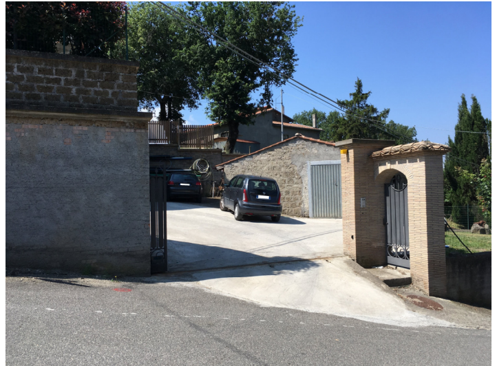
Foto n. 2: ingresso al piano seminterrato
