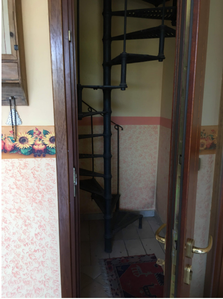
Foto n. 19: scala garage di collegamento ai piani superiori
