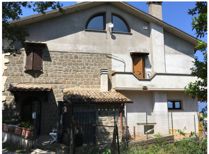
Foto n. 4: vista esterna del fabbricato pt
