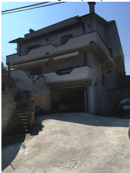
Foto n. 3: vista esterna del fabbricato ps1
