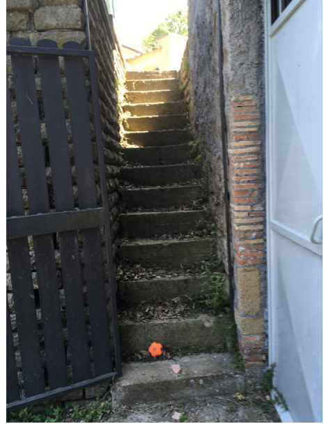
Foto n. 20: scala collegamento abitazione - garage
