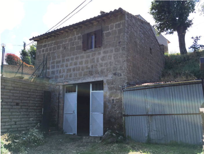
Foto n. 21: vista esterna del fabbricato ps1
