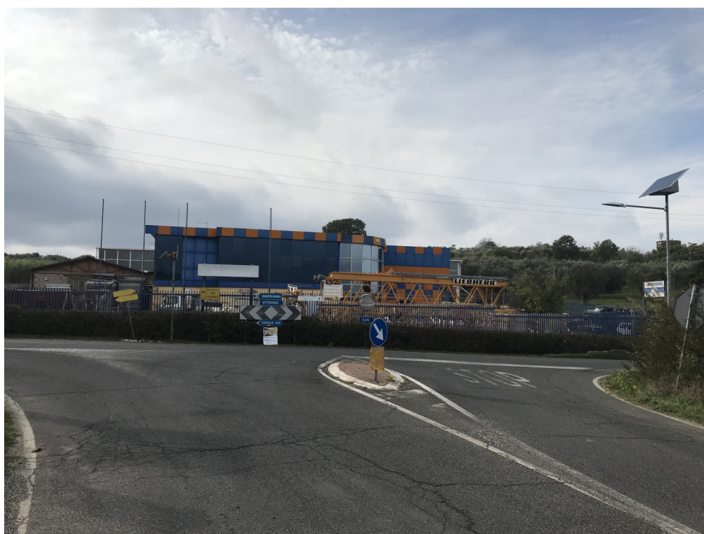
Foto 6 – Vista del corpo frontale
