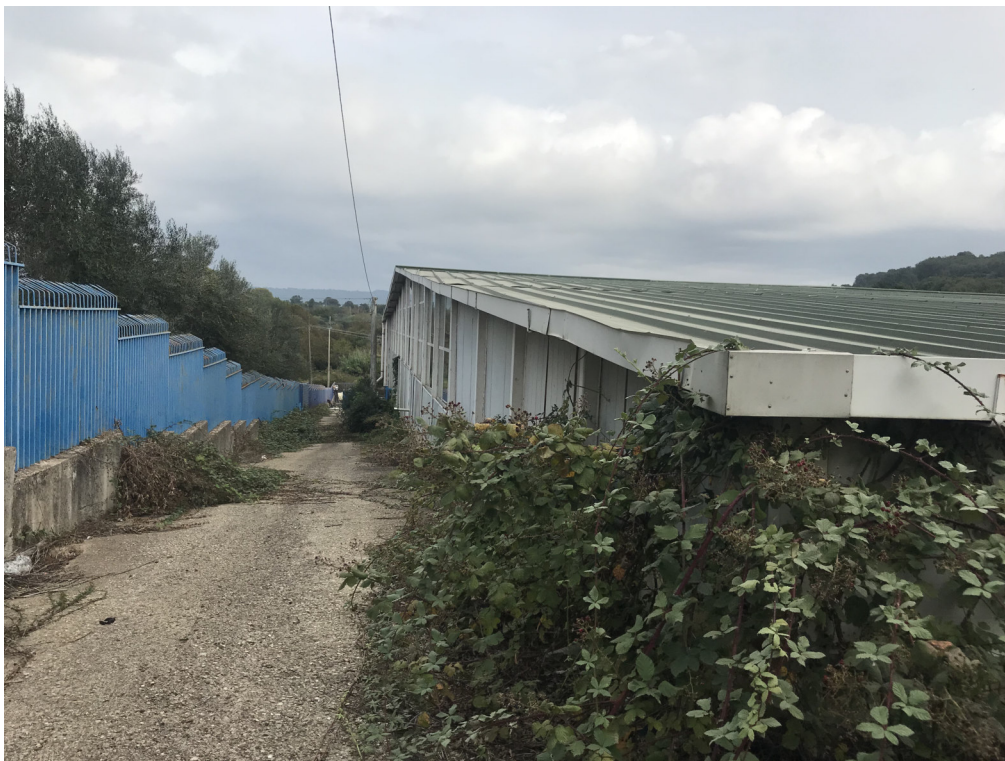
Foto 2 - Vista della recinzione al lotto
