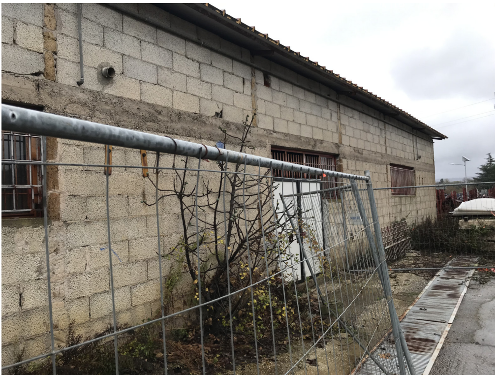
Foto 4 – Vista del corpo in muratura
