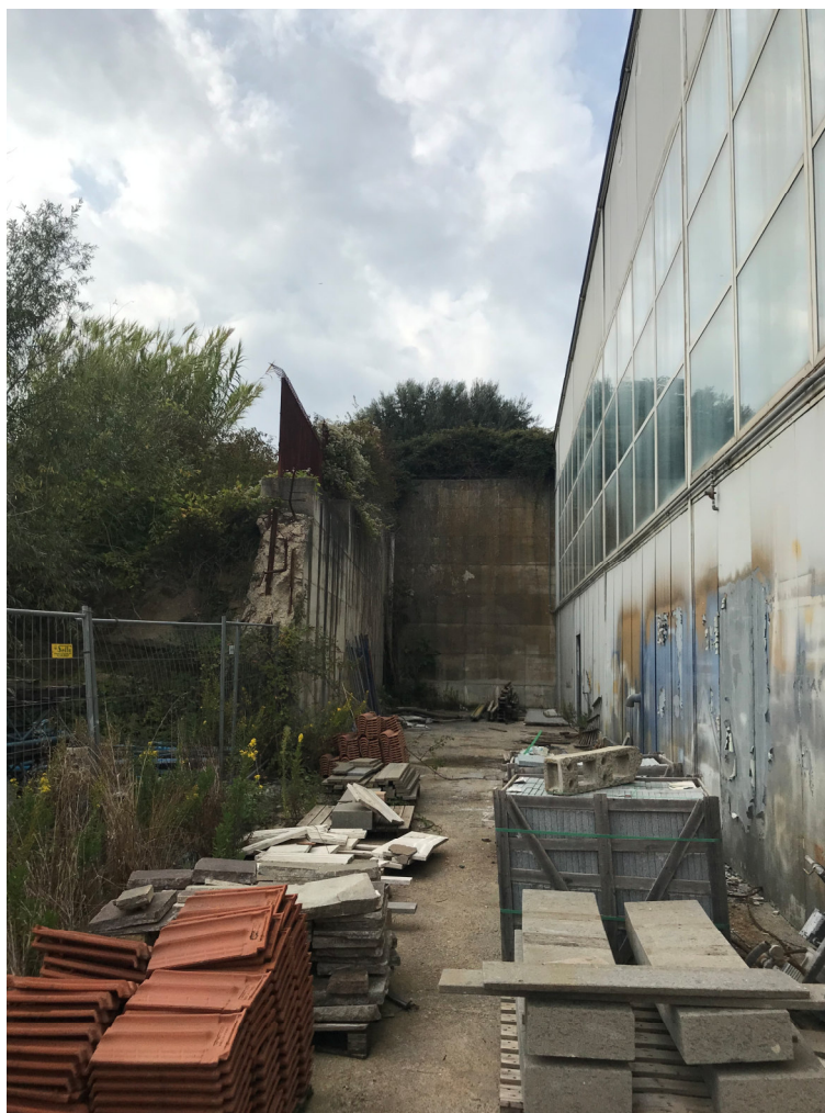
Foto 11 – Vista dello sbancamento laterale da ripristinare
