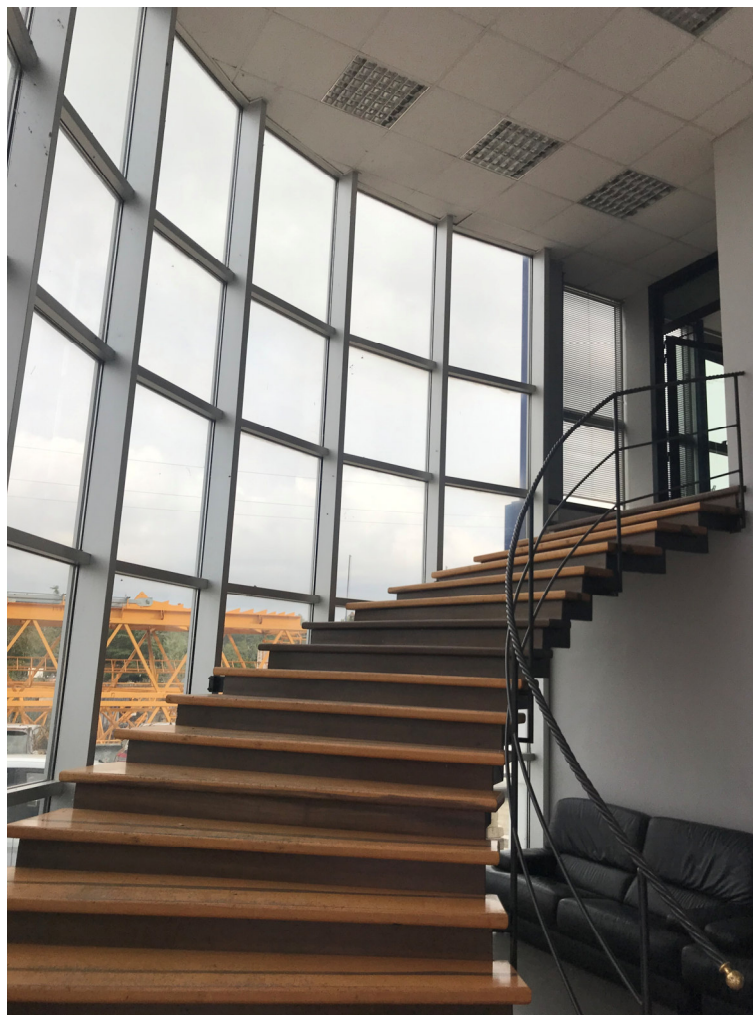
Foto 7 – Vista della scala di accesso al livello superiore
