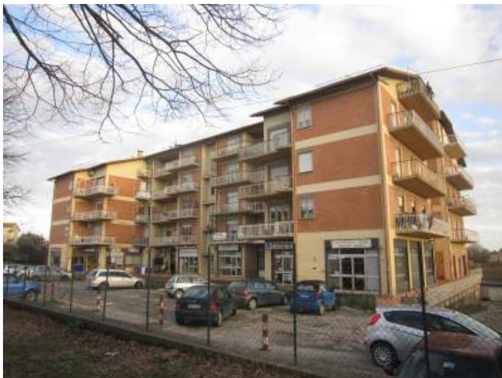
Foto 1 – Vista esterna da Viale degli Eroi
