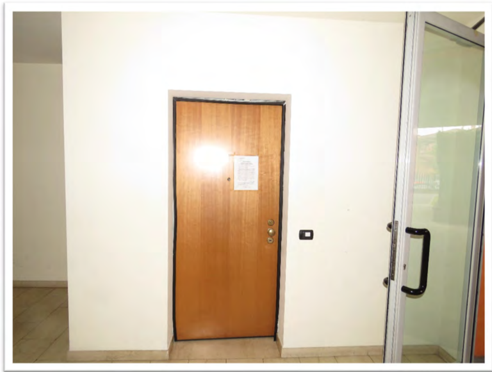
Particolare interno ed esterno all'alloggio in esame.
