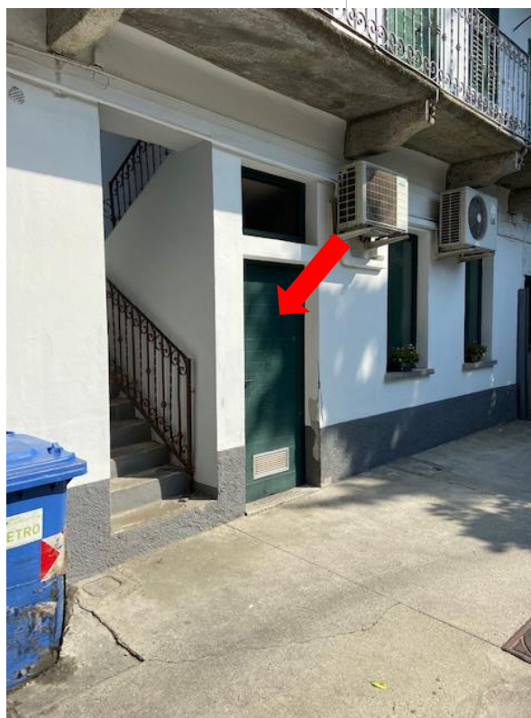
VISTE RIPOSTIGLIO IN CORTILE
