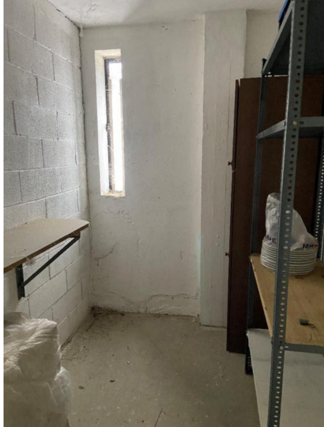
vista vano cantina
