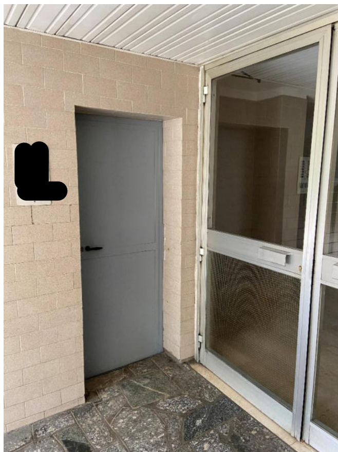
vista porta di accesso ai vani cantinati
