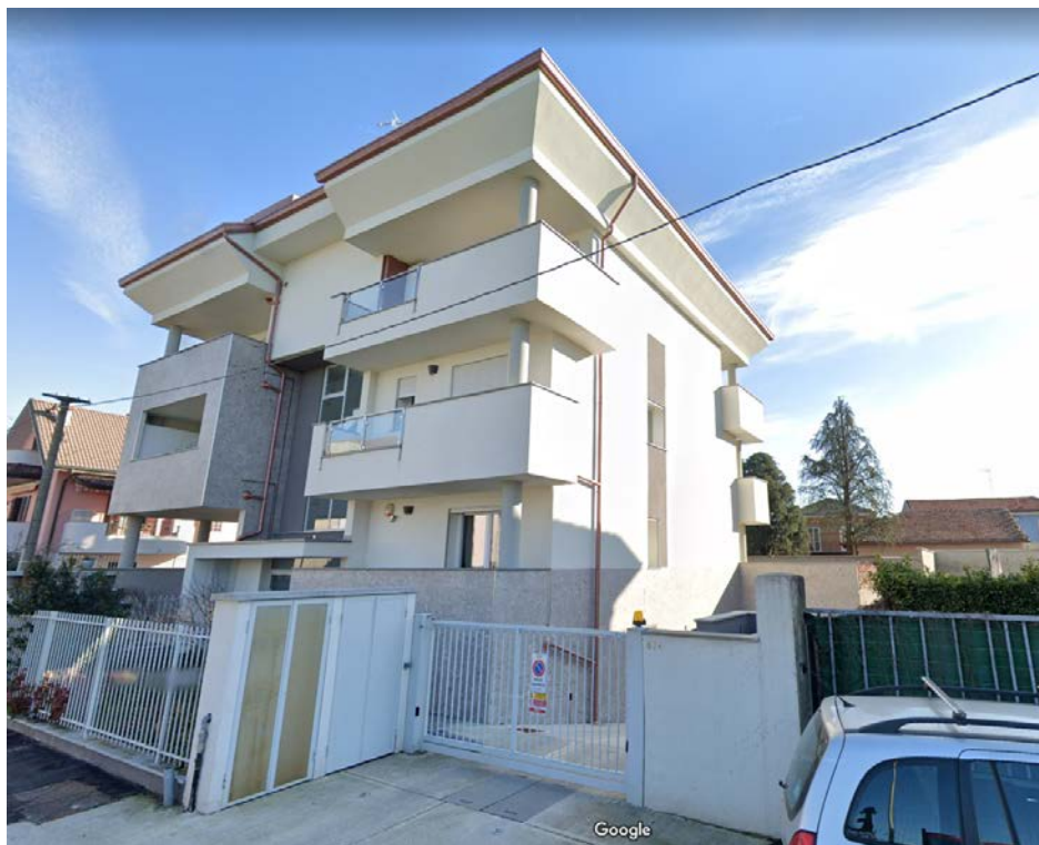
Foto n. 1: Prospetto principale della palazzina su Via Bettinetti
