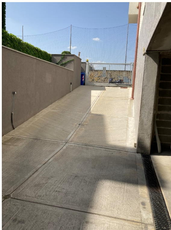
Foto n. 3: Rampa di accesso ai box posti al piano S1
