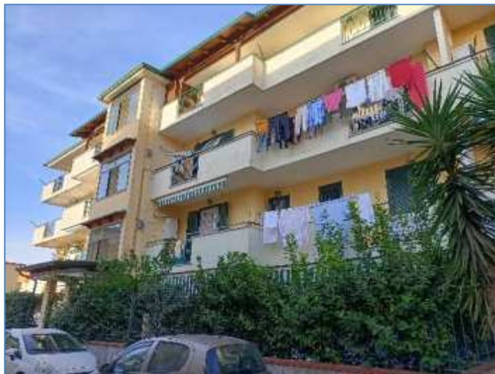
Fotografia 1 – Prospetto su via Campanella
