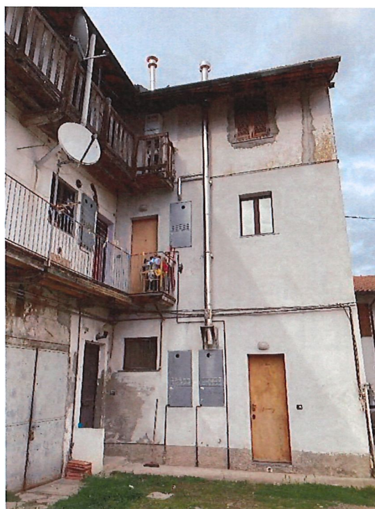
Foto n. 2: Prospetto principale su cortile interno
