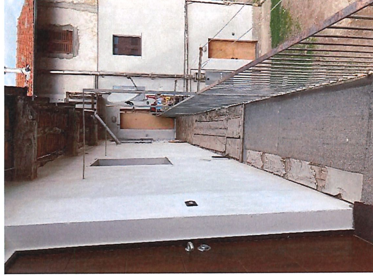
Foto n. 5: Particolare ballatoio comune
