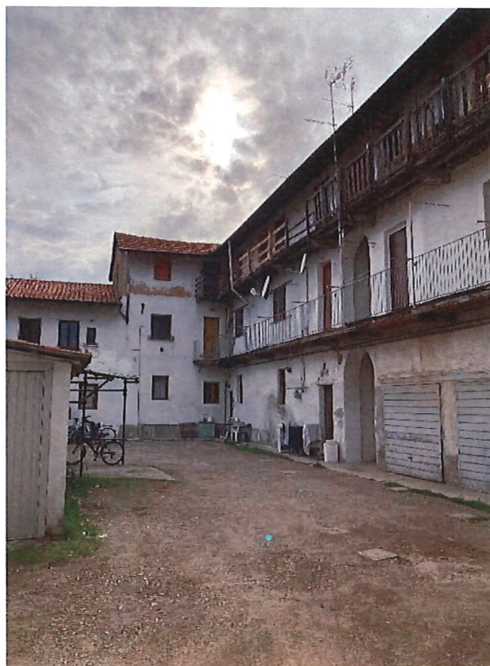
Foto n. 1: Prospetto principale su cortile interno
