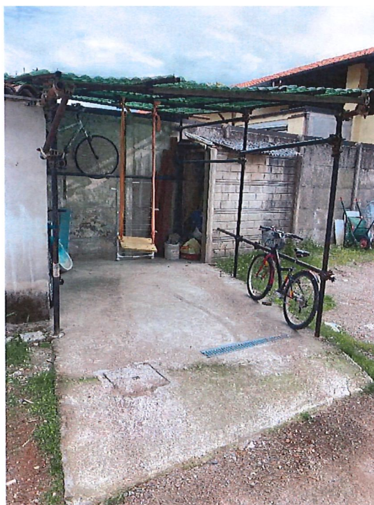
Foto n. 14: Posto auto (sub 706)
