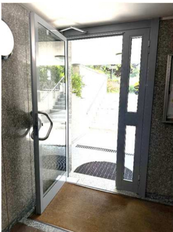
6. Dettaglio del portone di ingresso.
