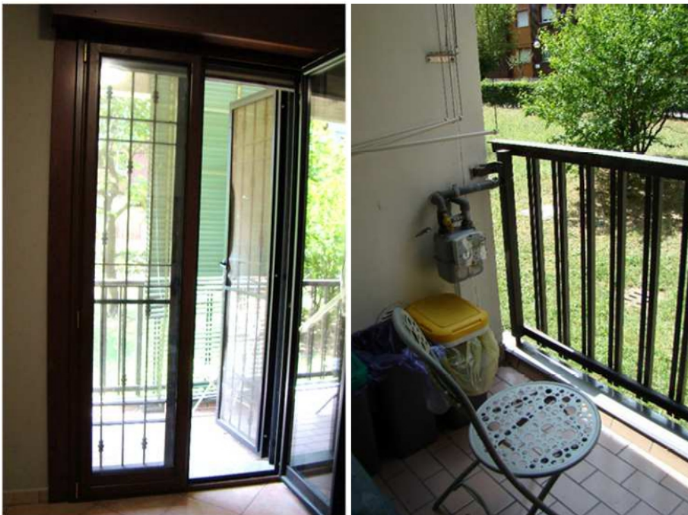
12. Viste del balcone.
