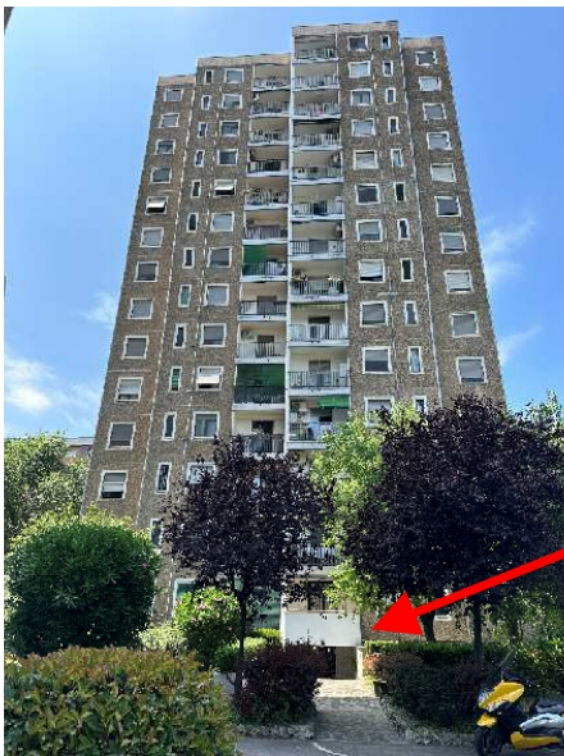
3. Vista dell'ingresso all'edificio.
