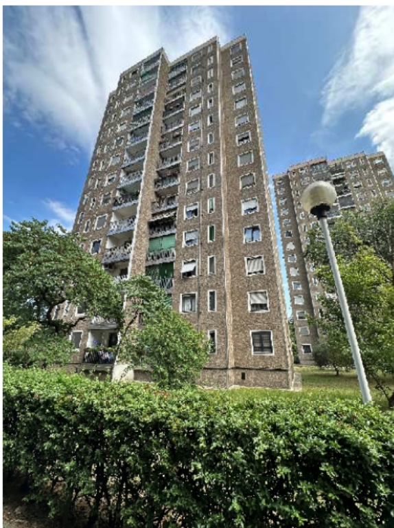
4. Vista degli affacci dal vialetto sul retro.
