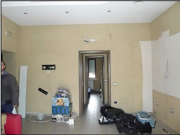
16. A destra l'angolo cottura, di fronte il disimpegno tra camera da Letto L1 e bagno
