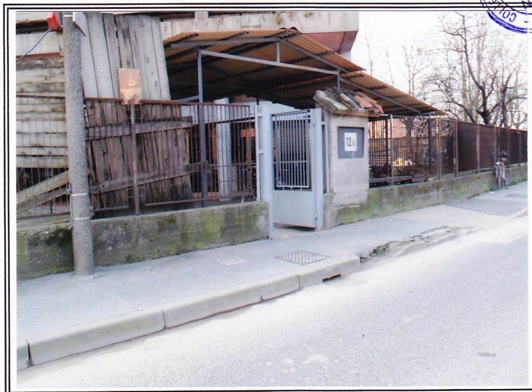
Esterno fabbricato – ingresso pedonale
