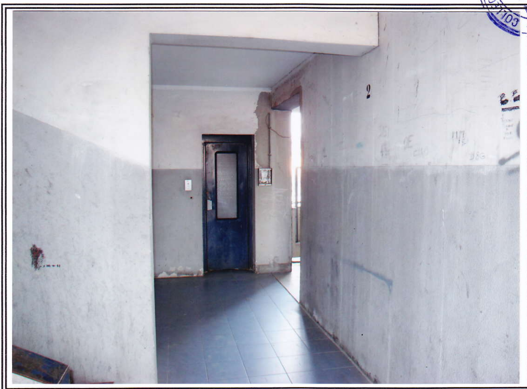
Interno fabbricato – parti comuni al piano secondo
