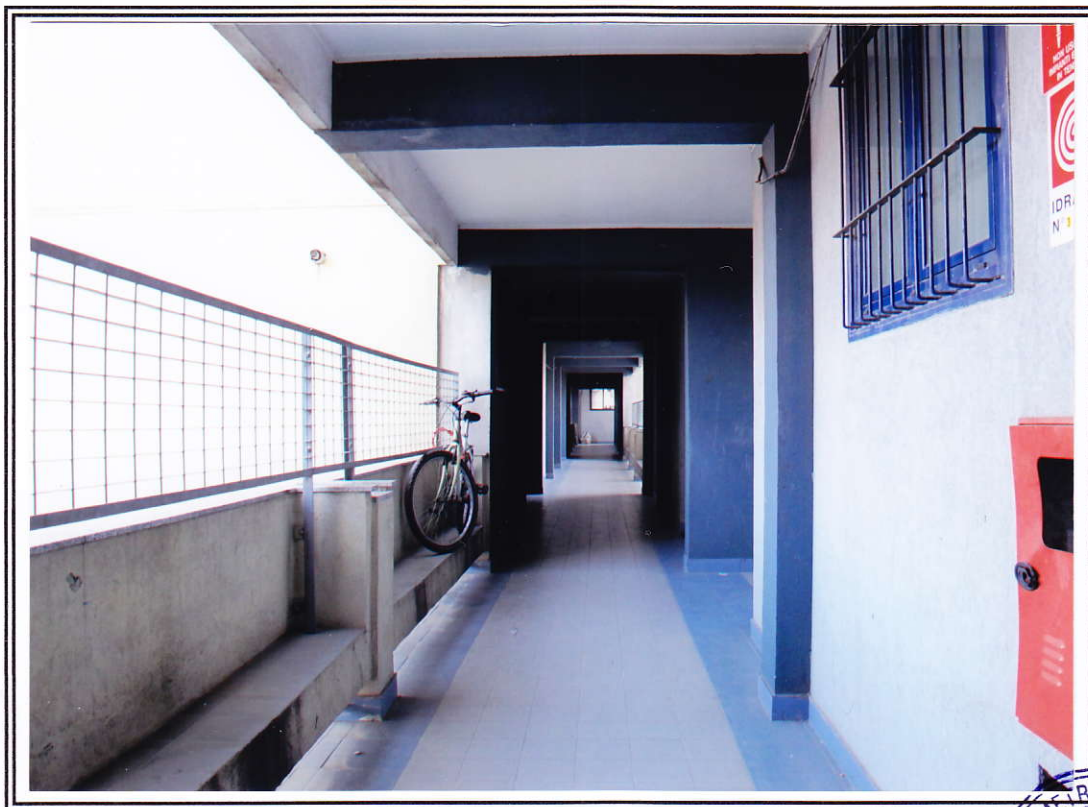
Interno fabbricato – parti comuni al piano secondo
