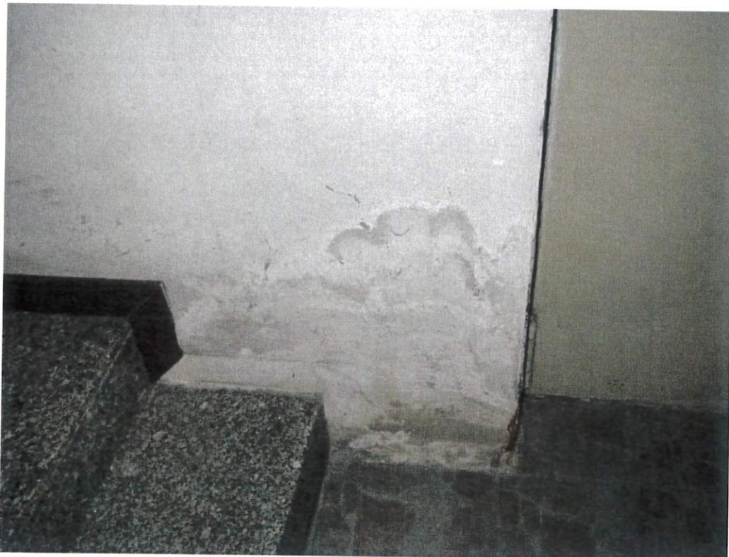
Dettagli - Muffa in corrispondenza del piano secondo interrato
