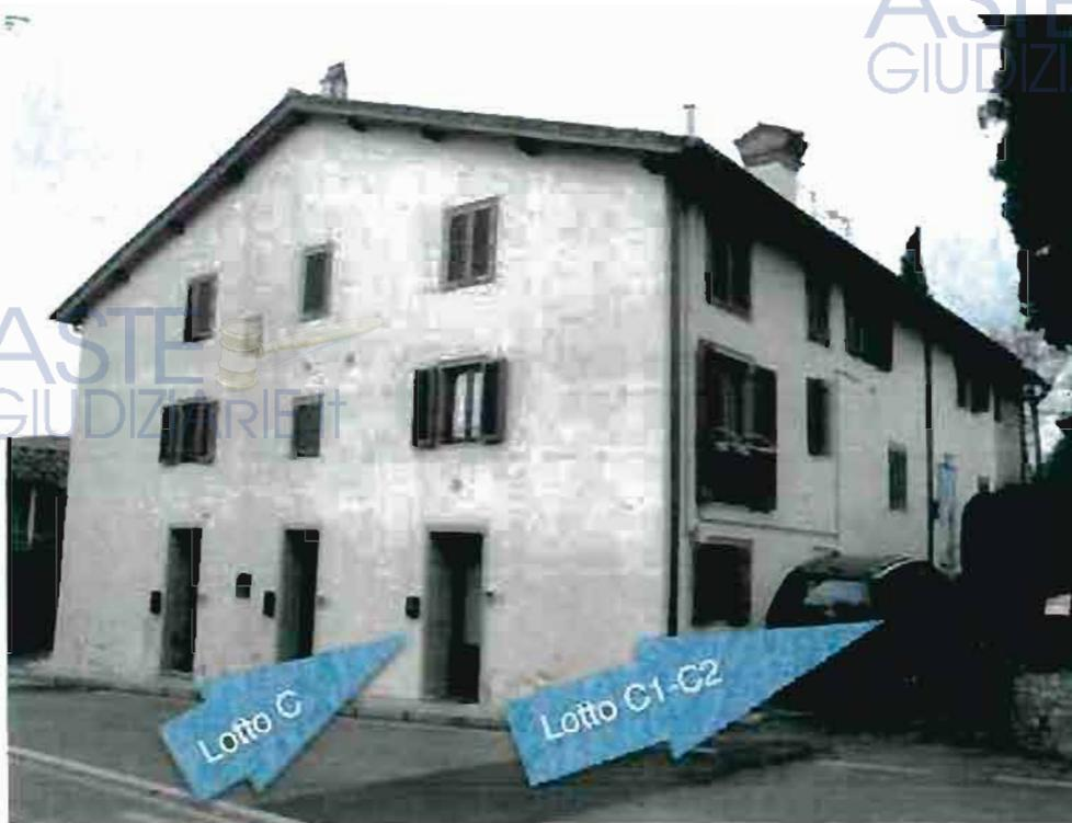
Le caratteristiche costruttive del fabbricato è con struttura portante in elevazione e orizzontale in muratura tradizionale, tamponature interne e esterne in laterizio e copertura a falde. I prospetti esterni sono intonacati ed hanno lineamenti semplici con finestre e porte posizionate regolarmente.
